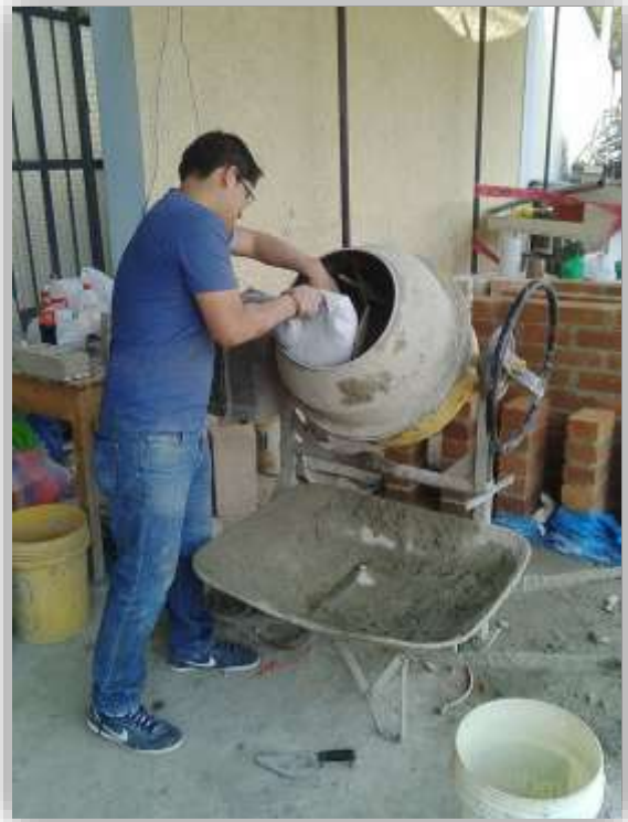
Foto N°08 y 09: Preparación de las mezclas de concreto
