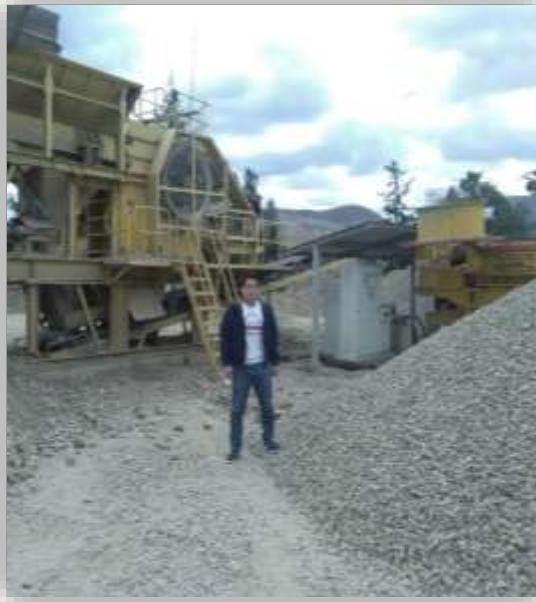
Foto N°01: Elección de la cantera y agregados para la investigación, Cantera "Acosta", Baños del Inca.
