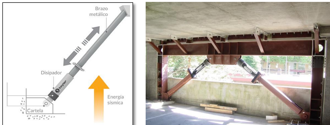
Fig. 9. Disipador de fluido viscoso Taylor. Fuente: CDV ingeniería antisísmica
