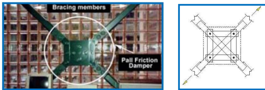
Fig. 7. Disipador por fricción. Fuente: Villareal, G. y Oviedo, R. 2008 pag.39
