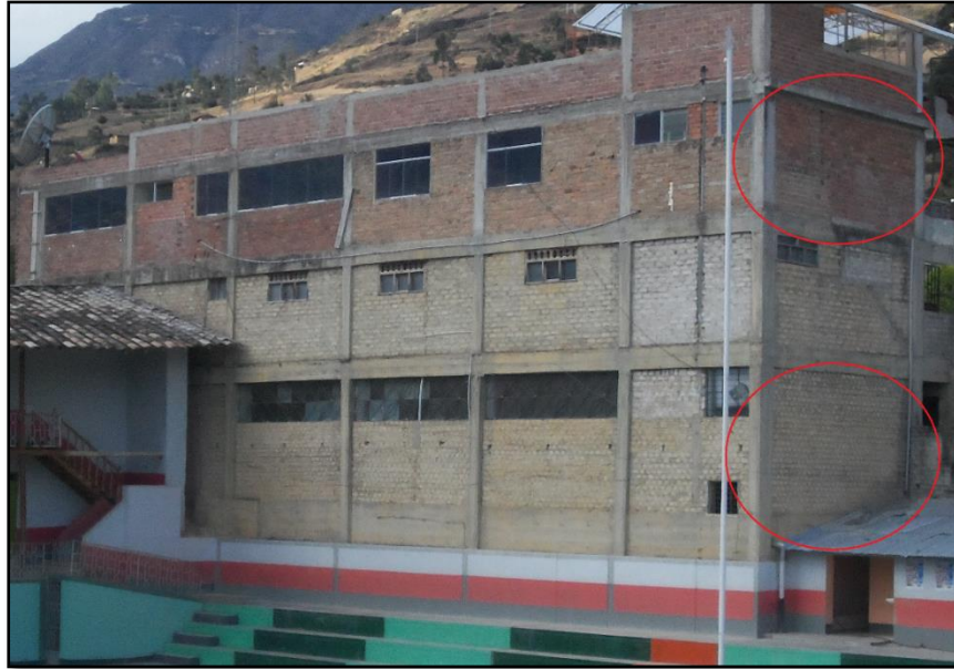
Fig. 38: Muros confinados por pórticos de concreto
