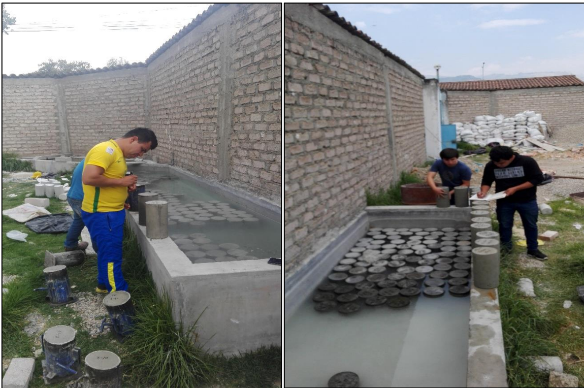
FOTO N°06: Desencofrado, traslado, codificación e ingreso de especímenes a la poza de curado del Laboratorio de Ensayo de Materiales de la UNC.
