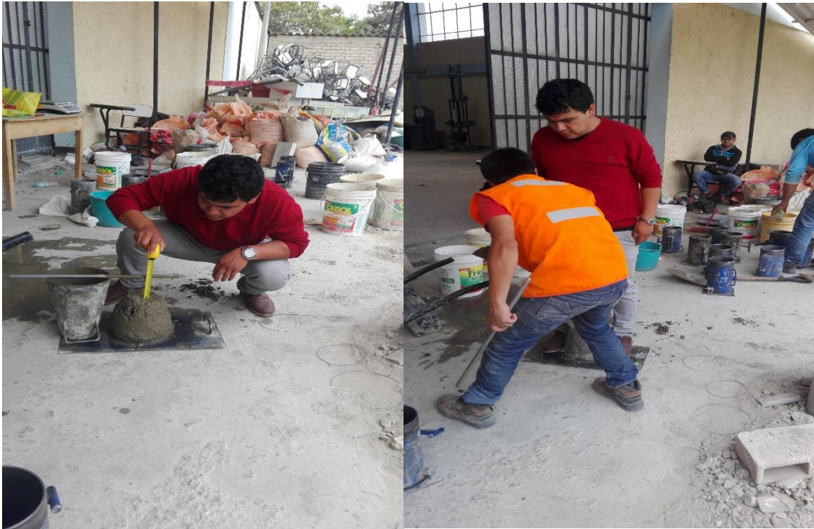
FOTO N°07: Medición del Slump, ensayo para determinar la consistencia de las mezclas de concreto.
