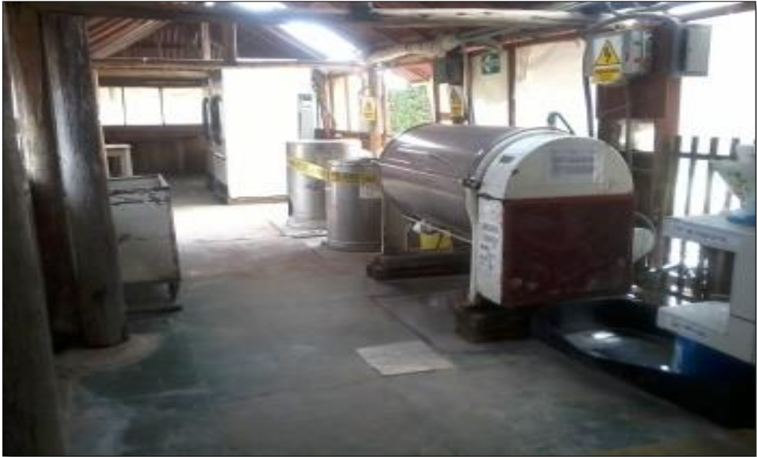
Fotografía 09: Inicio del proceso en equipos.
