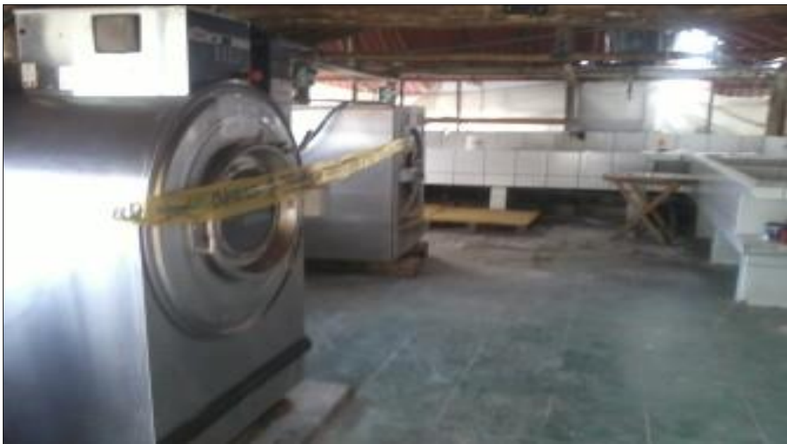
Fotografía 08: Inicio del proceso en equipos.
