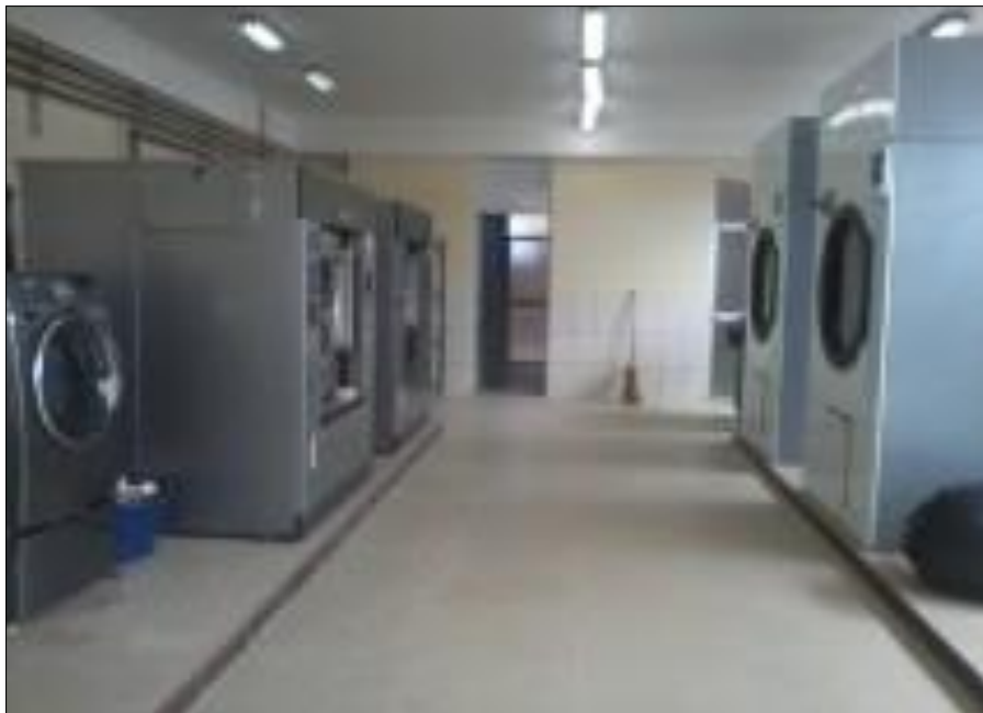
Fotografía 15: Despejar rutas de acceso y correcta ubicación de máquinas.
