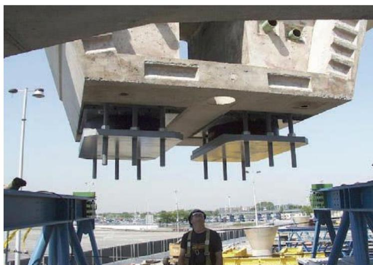
**Figura 2-21** Aisladores de goma con núcleo de plomo instalado en el viaducto ferroviario ligero del aeropuerto JFK, Nueva York. (Buckle I. et al., 2006)
