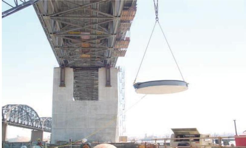
**Figura 2-22** Aislador de péndulo fricción instalado en el puente Benecia-Martinez, California. (Buckle I. et al., 2006)
