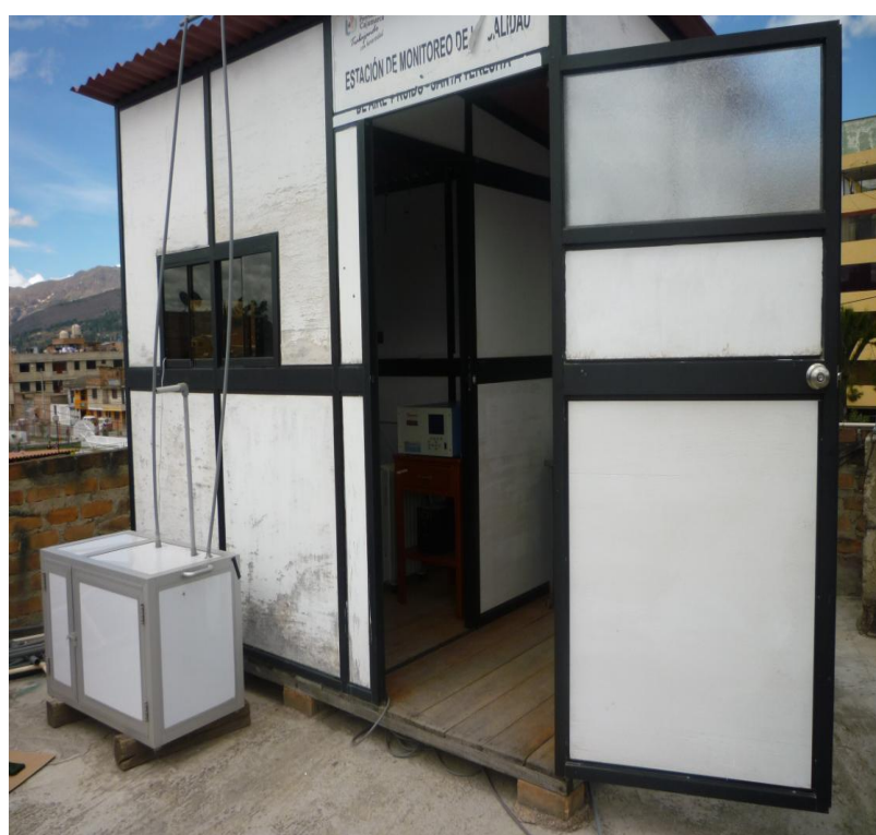
Figura 8. Estacion de monitoreo de Municipalidad Provincial Cajamarca ubicada en el Jr. Mariano Melgar N° 311-Barrio La Colmena Baja.
