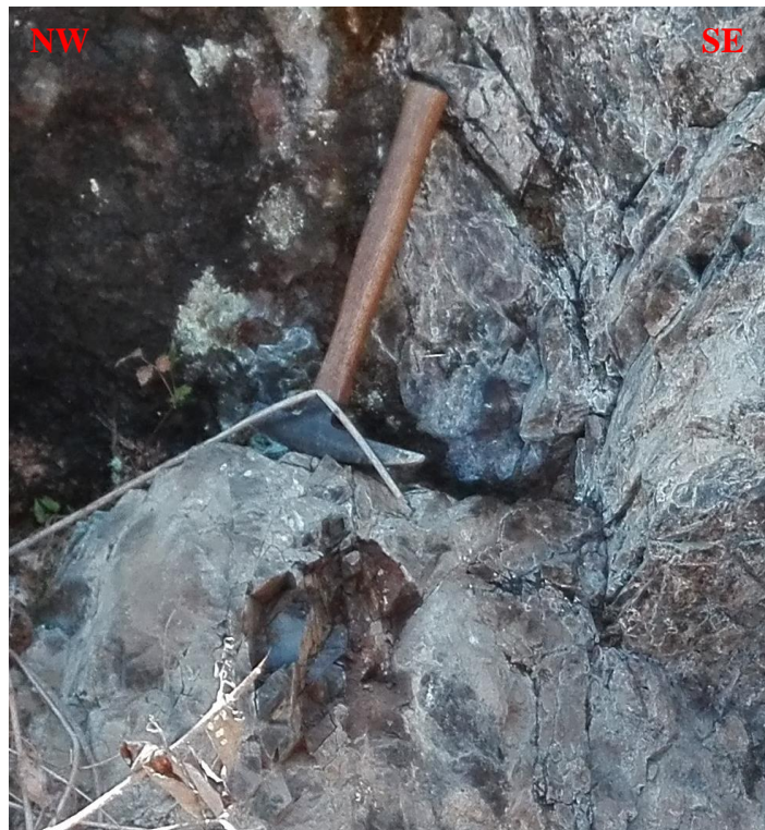
Figura 39. Limolitas oscuras fuertemente fracturadas por el contacto con el intrusivo.
