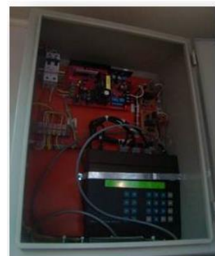
Fig. 15: Reloj digital con conexiones dentro de caja nema
