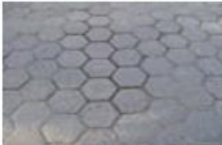
Figura 17. Juntas Abiertas (Higuera, Pacheco, 2010, p. 85).
