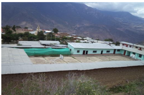
Figura 21 Panorama Interior de la IE. N° 82264 de San Luis Grande, registro fotográfico: 15-03-2014
