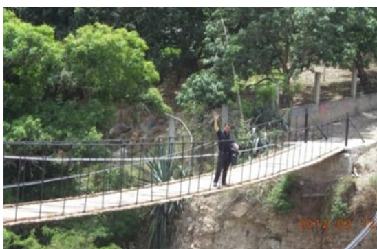
Figura 23 Puente colgante de Las Paltas, registro fotográfico: 15-03-2014
