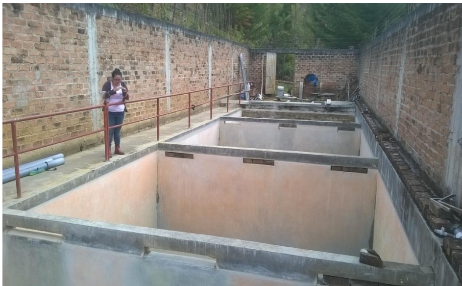
Figura 28. Toma de fotografías en el momento de mantenimiento y limpieza de la planta de tratamiento de agua potable de Sucre
