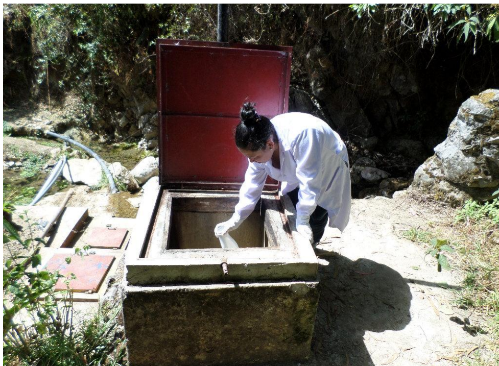
Figura 21. Toma de muestra de agua de la captación del Manantial La Quintilla
