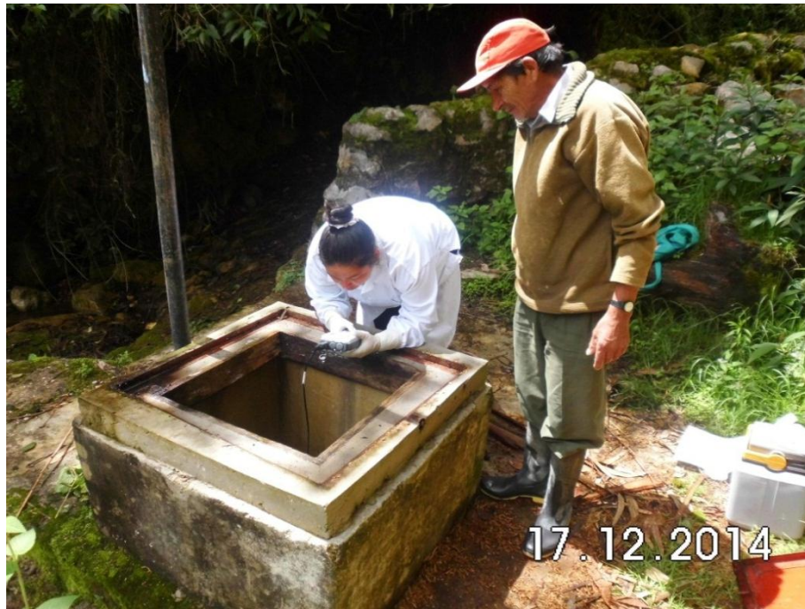
Figura 15. Toma de muestra de agua de la captación del sistema de agua potable
