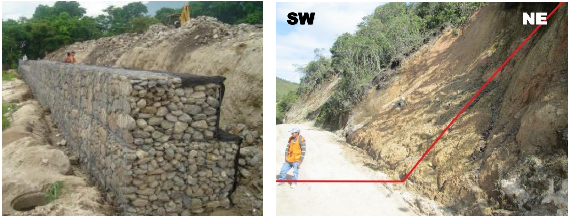
Foto N° 14: Como se va a colocar los gaviones en este tramo.
