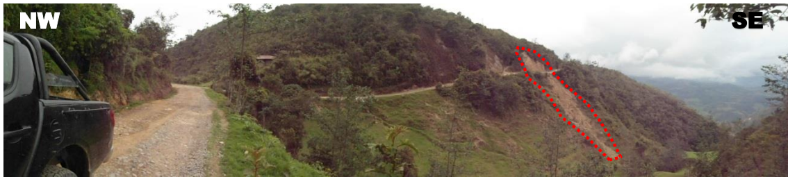
Foto N° 1: Deslizamiento rotacional de un suelo Areno-Limoso en el tramo Km 6+475 - 6+518
