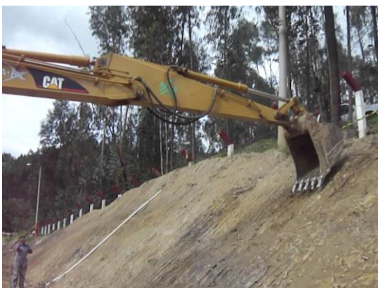
Foto N° 13: Bajando ángulo de talud a 45°
