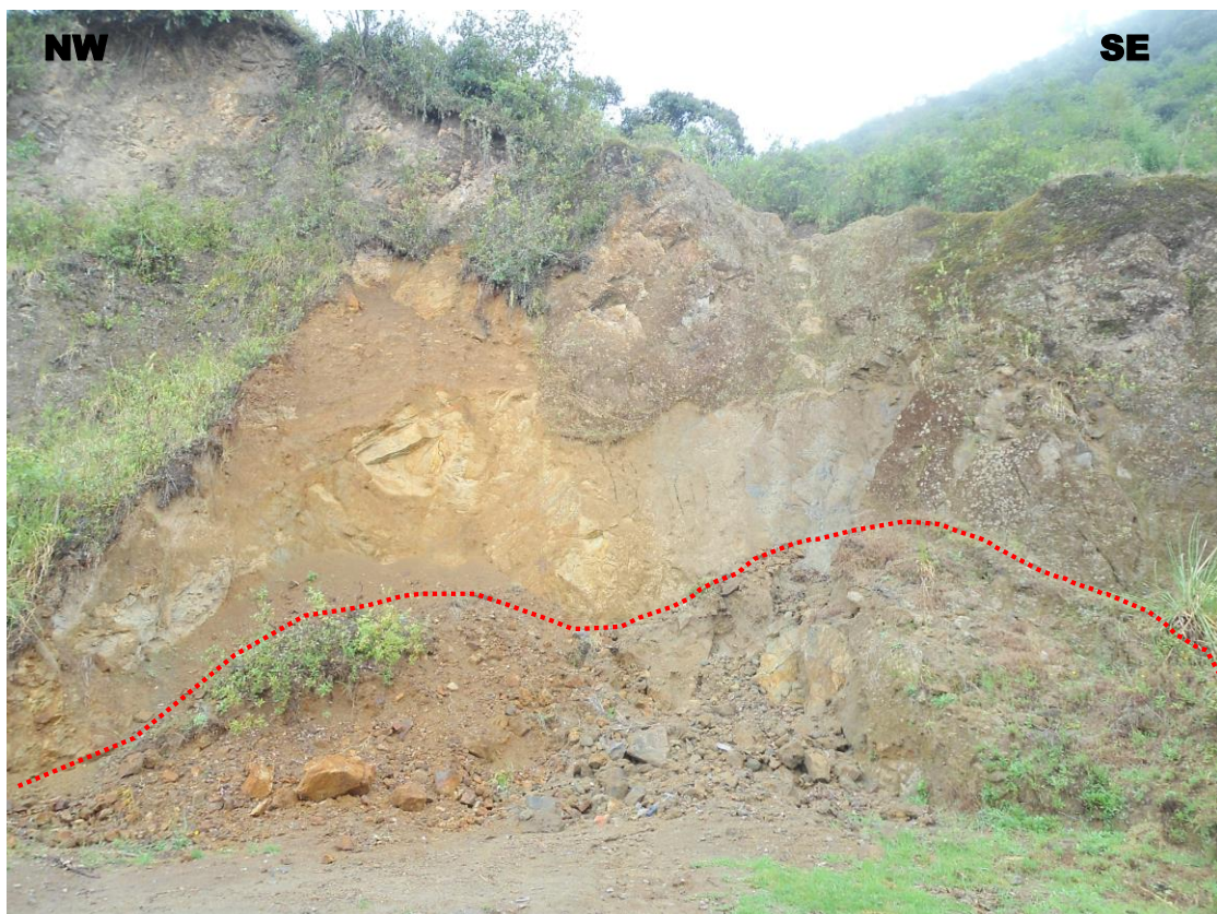
Foto N° 2: Caída de rocas muy alteradas en la progresiva Km 1+390 - 1+460
