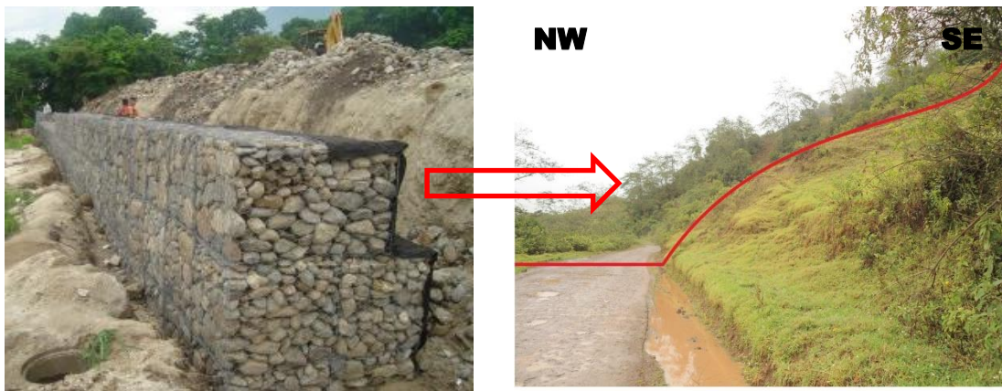
Foto N° 12: Instalación de Gaviones
