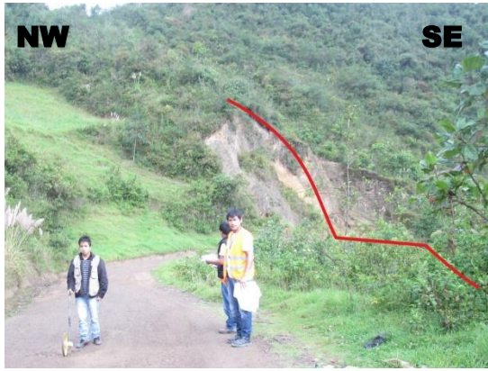
Foto N° 5: Deslizamiento de roca volcánica de en la progresiva Km 1+390 - 1+460.
