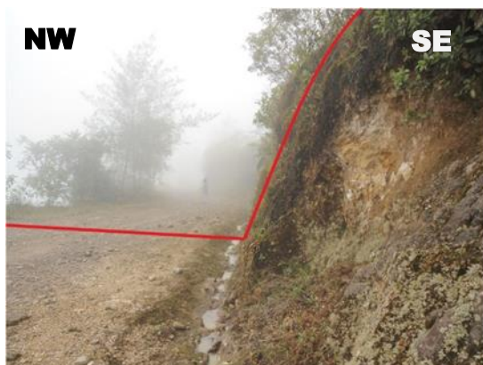
Foto N° 13: Bajando ángulo de talud a 45°
