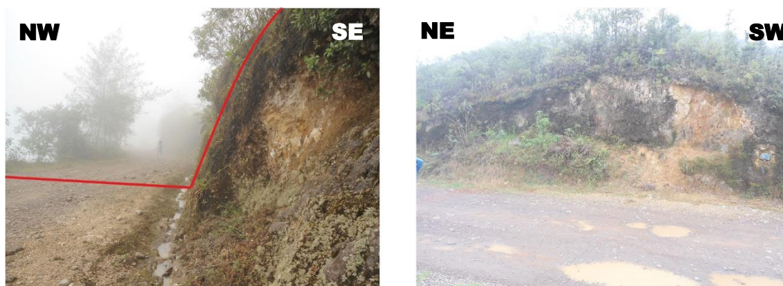
Foto N° 9: Roca volcánica andesítica de color amarillento en la progresiva Km 5+300 - 5+340
