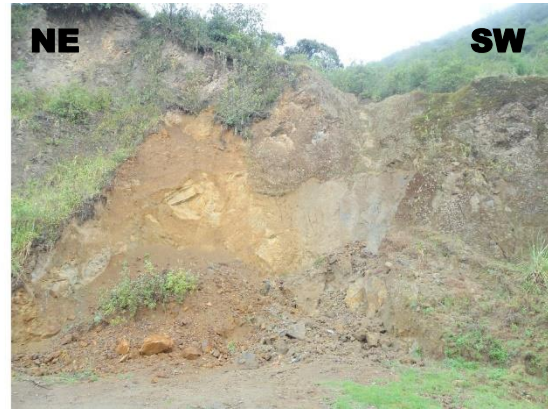
Foto N° 5: Deslizamiento de roca volcánica de en la progresiva Km 1+390 - 1+460.
