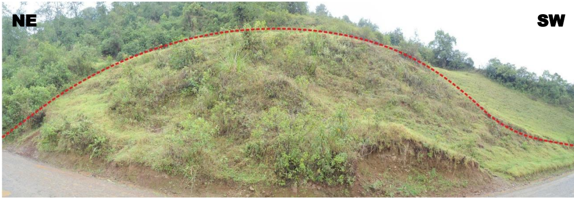
Foto N° 6: Vista de un deslizamiento rotacional antiguo en la progresiva Km 1+570 - 1+670
