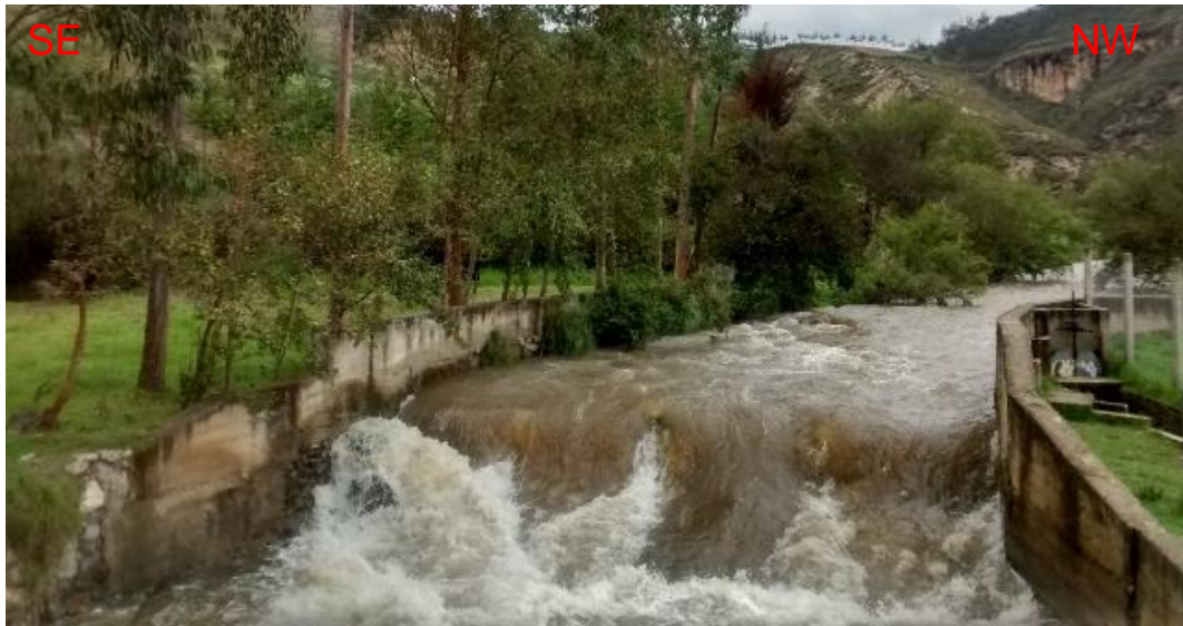
Figura 41: Punto más alto de la cuenca del río Chonta dentro del distrito de Baños del Inca
