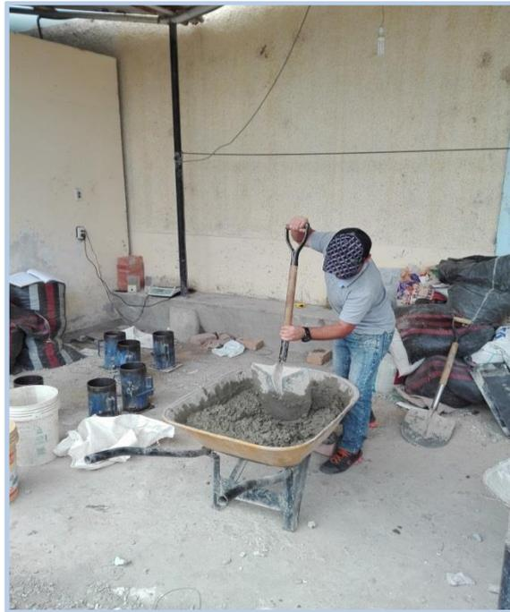
**Figura 32.**Preparación de la mezcla de concreto.
