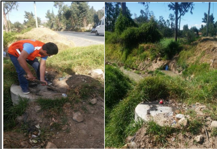
FOTO 03: Reconocimiento de la zona - Identificacion de Buzones colector Victoria
