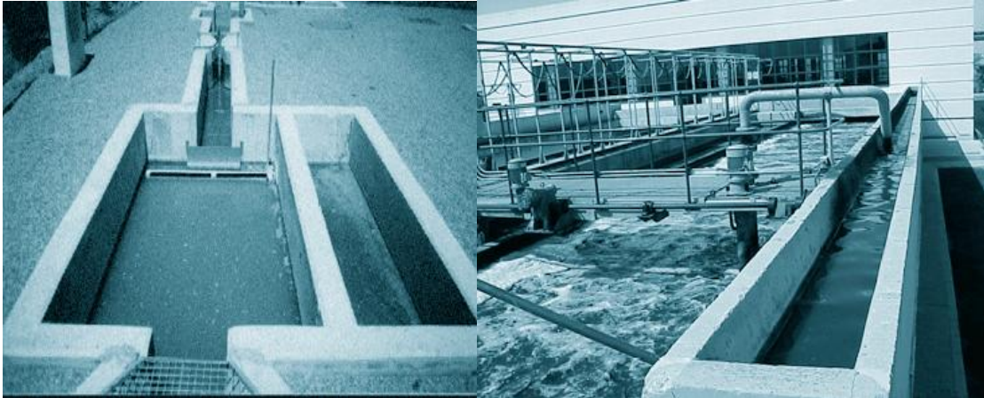
Figura 7 Desengrasador estático vs desarenador - desengrasador aireado
