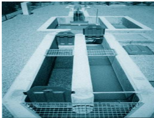
Figura 6 Desarenador de doble canal
