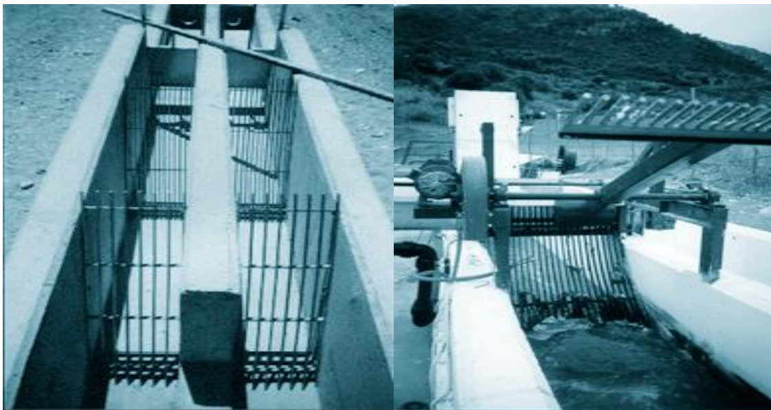
Figura 5 Desbaste de gruesos seguido de desbaste de finos vs reja curva de acondicionamiento automático
