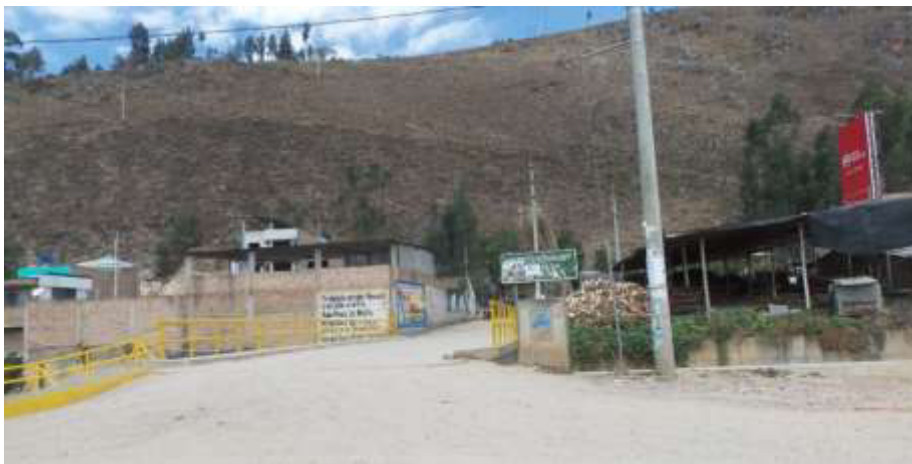
Figura N° 80 . Puente Chinchimachay en el cauce del río.
