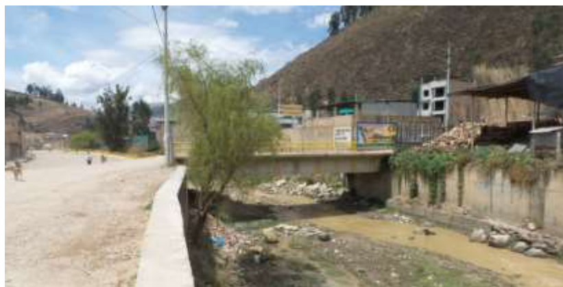
Figura N° 36. Inicio del Levantamiento en el punto de descarga
