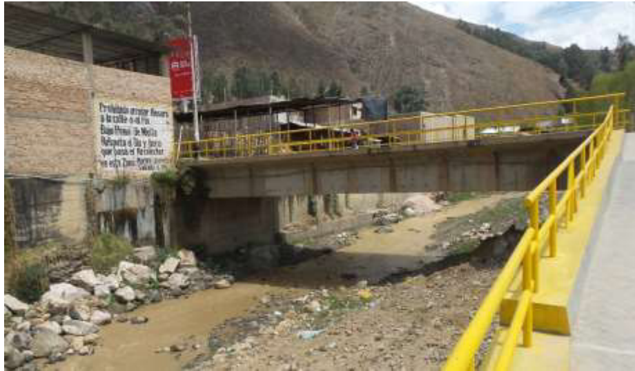
Figura N° 27. Vista del puente Chinchimachay
