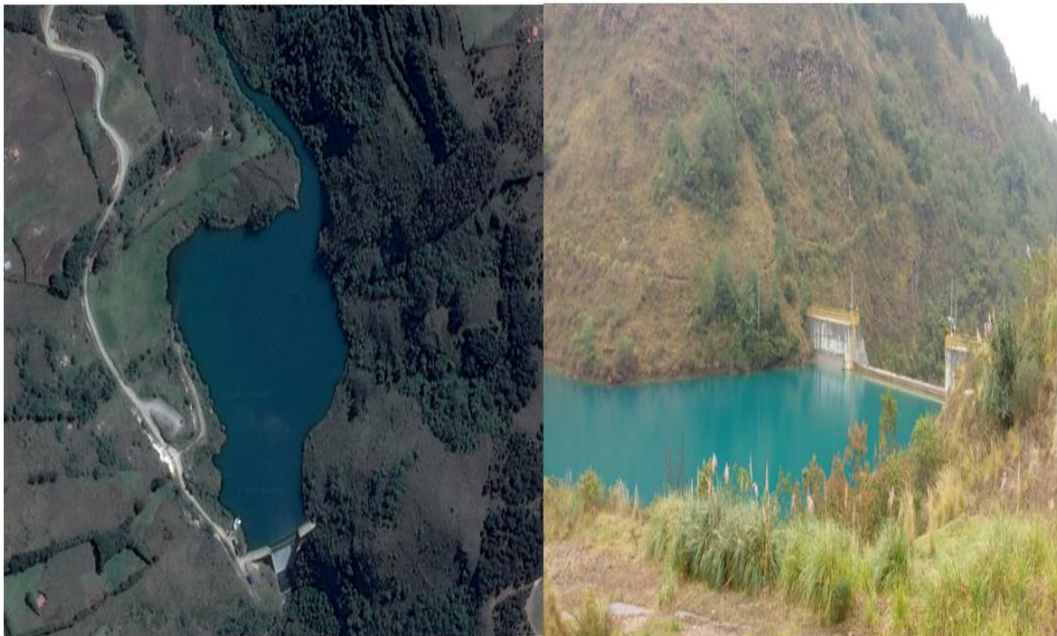
Figura 20. Dique “Río Grande” de minera Yanacocha, en el mes de Setiembre, 2017.
