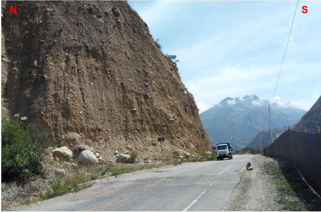
Foto 15: Talud compuesto por suelos semi-consolidado.
