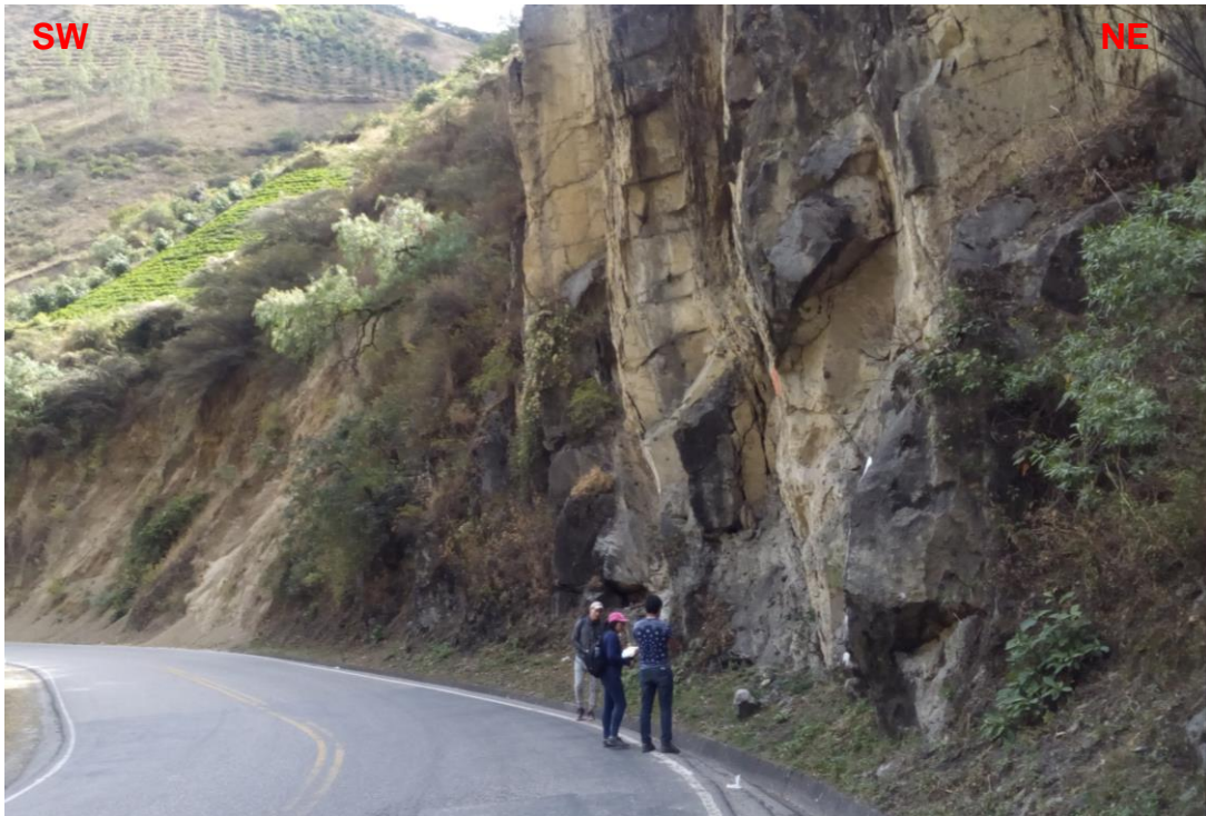
Foto 21: Talud compuesto por calizas de color amarillentas por meteorización de la Formación Yumagual.
