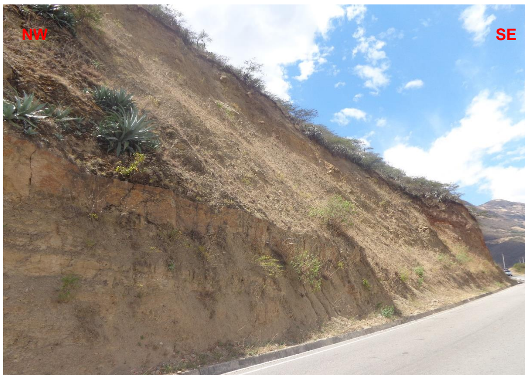
Foto 12: Talud compuesto por caliza y lutita de la Formación Chulec.
