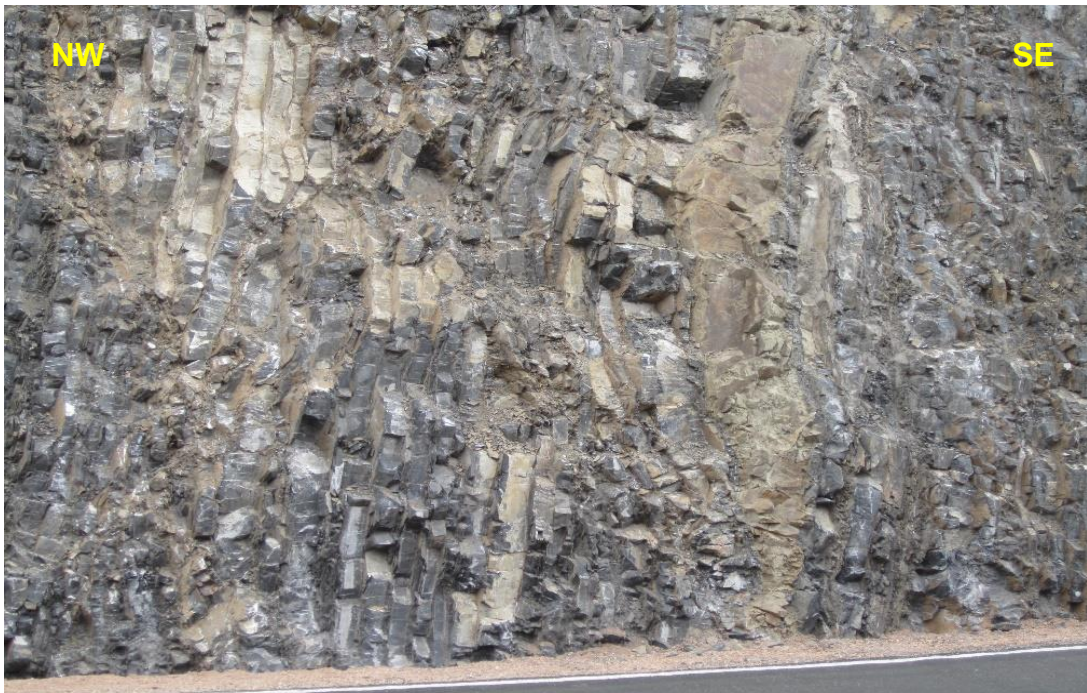
Foto 4: Calizas bituminosas con intercalación de lutitas km 130+650, zona Los Naranjos.
