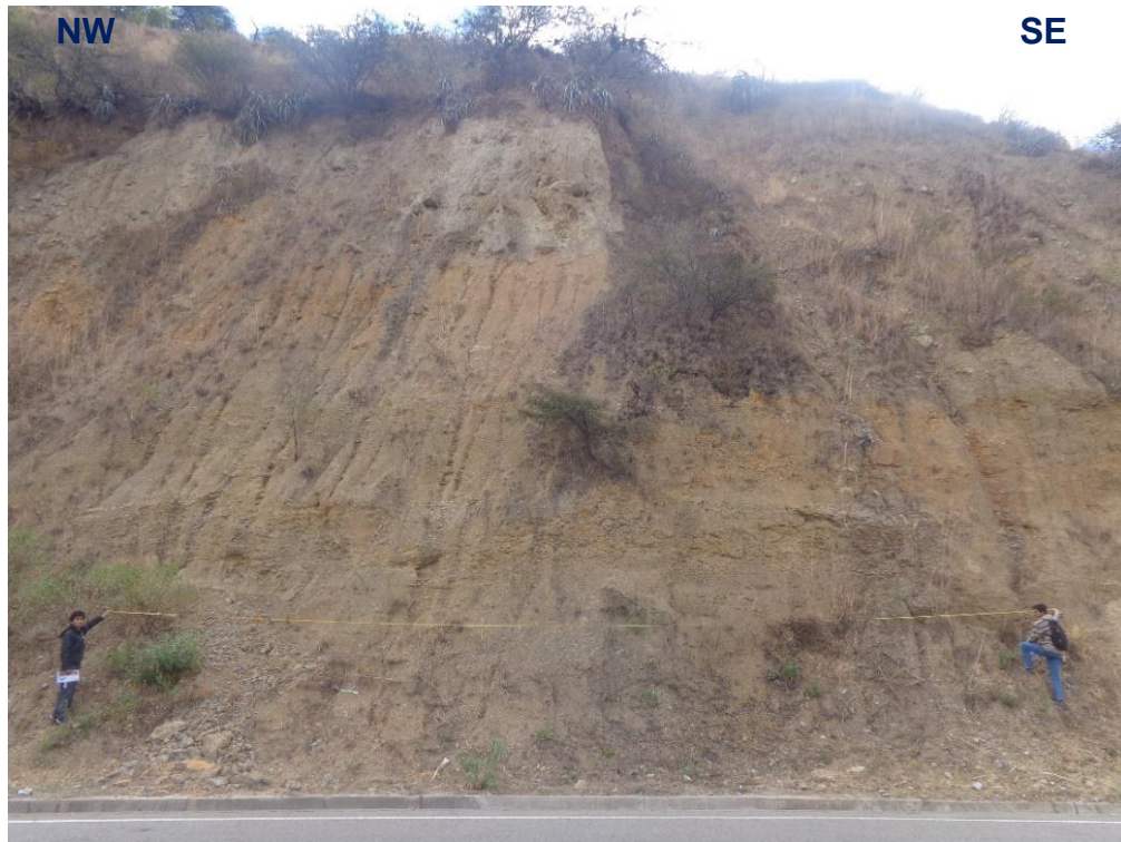
Foto 13: Talud compuesto por caliza y lutita de la Formación Chulec.
