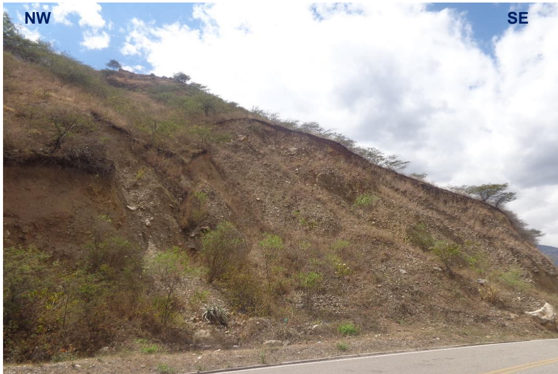
Foto 14: Talud compuesto por suelo semi-consolidado.
