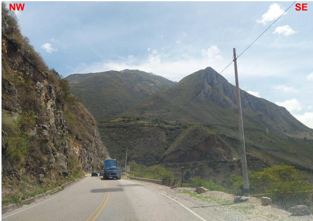
Foto 17: Talud compuesto por calizas de la Formación Yumagual.
