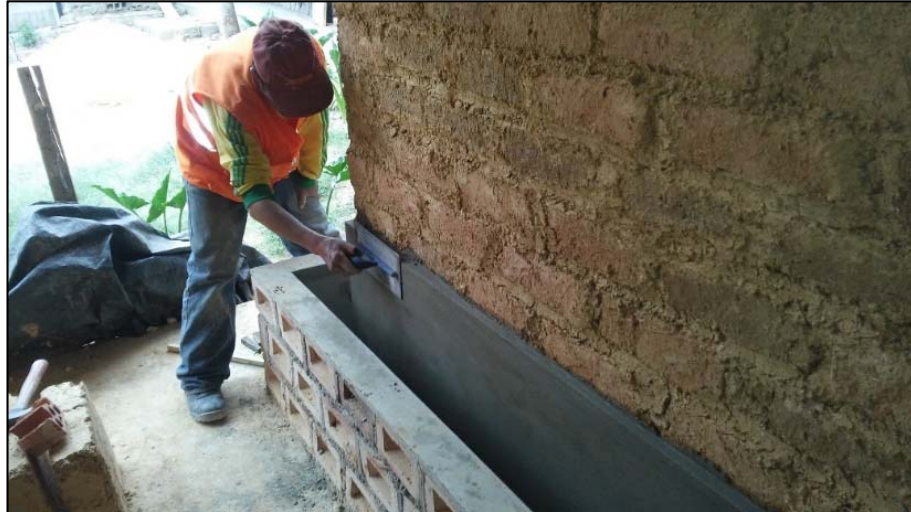
Figura N° 9: Tarrajeo de las caras del Muro MT.
