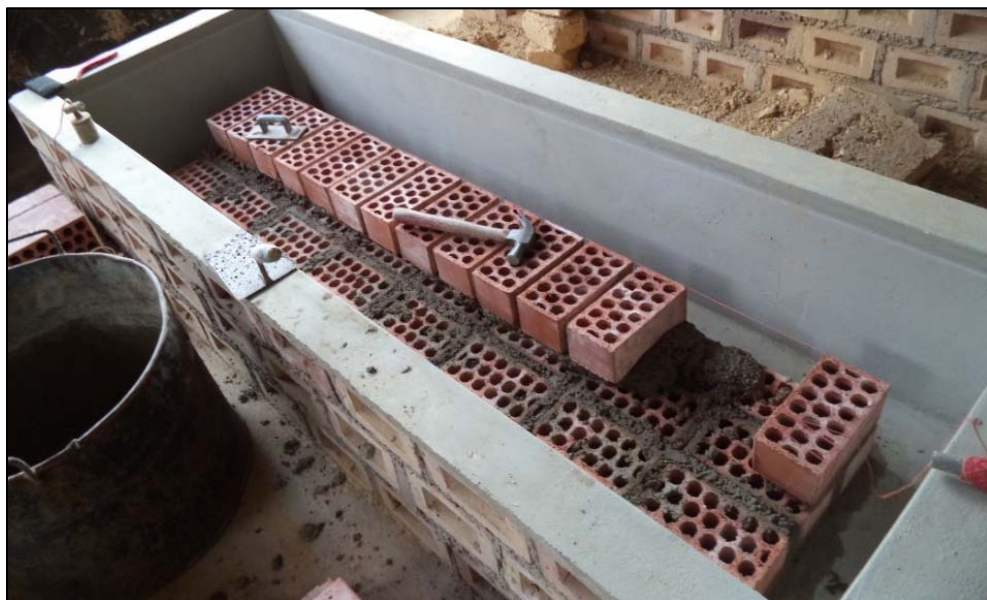
Figura N° 18: Asentado del sobrecimiento de ladrillo KK de arcilla industrial para el Muro ML.
