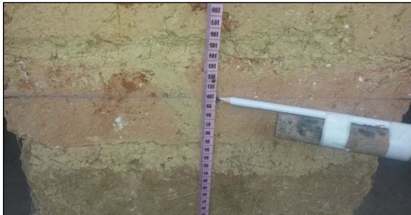
Figura N° 96: Nivel marcado en el Muro MT al finalizar el ensayo de inundación simulada para verificar asentamientos.
