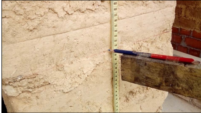
Figura N° 85: Nivel marcado en el Muro ME al finalizar el ensayo de inundación simulada para verificar asentamientos.
