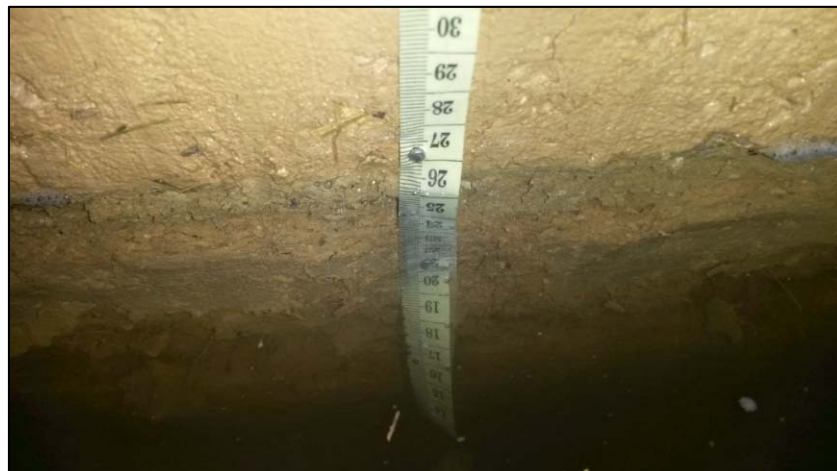
Figura N° 60: “Escamas” desprendiéndose de las caras del muro que está en contacto con el agua.
