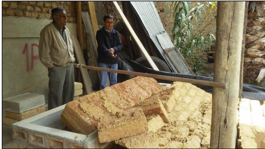
Figura N° 48: Maestriza y Asesor haciendo inspección ocular al Muro Patrón MP colapsado por efecto de la inundación simulada.
