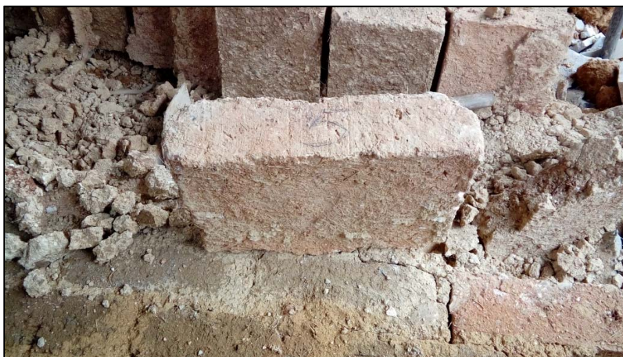
Figura N° 77: Adobe de la Hilera N° 05, sin humedad luego de ser retirado del muro MT.
