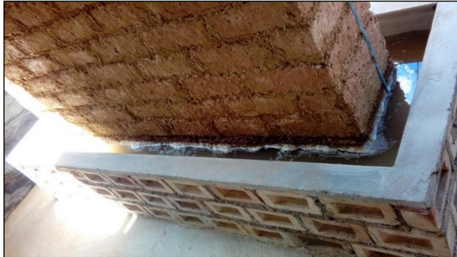
Figura N° 43: Muro Patrón (MP) después del llenado de la poza.
