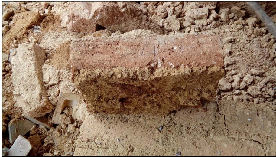
Figura N° 78: Adobe de la Hilera N° 04, con humedad parcial luego de ser retirado del muro MT.
