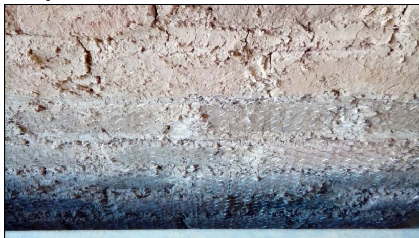
Figura N° 8: Malla de Gallinero anclada al muro de adobe.
