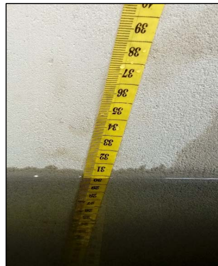
Figura N° 51: Cinta métrica para las lecturas ascenso capilar del agua en el Muro MT.
