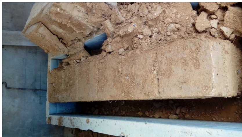
Figura N° 88: Hilera N° 04 del muro estabilizado ME.
