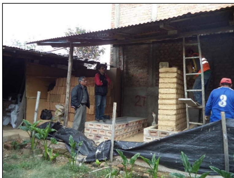
Figura N° 14: Asentado del Muro estabilizado.
