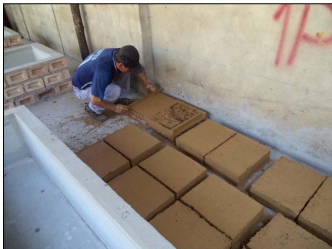
Figura N° 12: Moldeado de adobes estabilizados con 5% de cemento en peso, hechos en adobera "mellizera".
