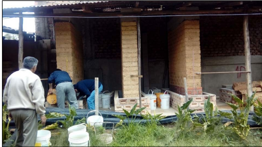
Figura N° 49: Llenado de la poza P2 donde se encuentra el Muro MT para el inicio del ensayo de inundación simulada bajo la inspección del Asesor.
