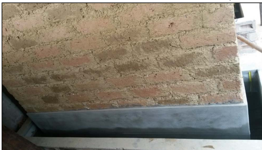
Figura N° 55: Muro MT al terminar el Periodo Corto de Inundación (Cara lateral).
