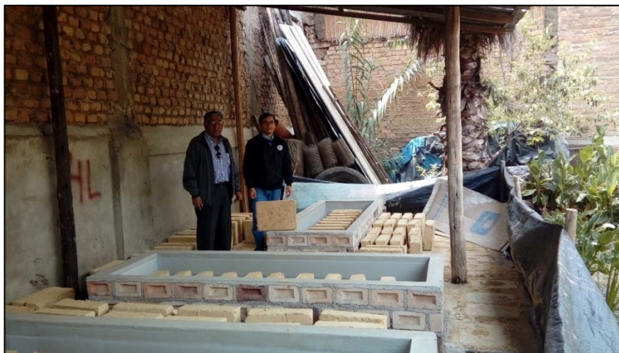
Figura N° 13: Visita e Inspección del Asesor a los adobes estabilizados en el proceso de secado.
