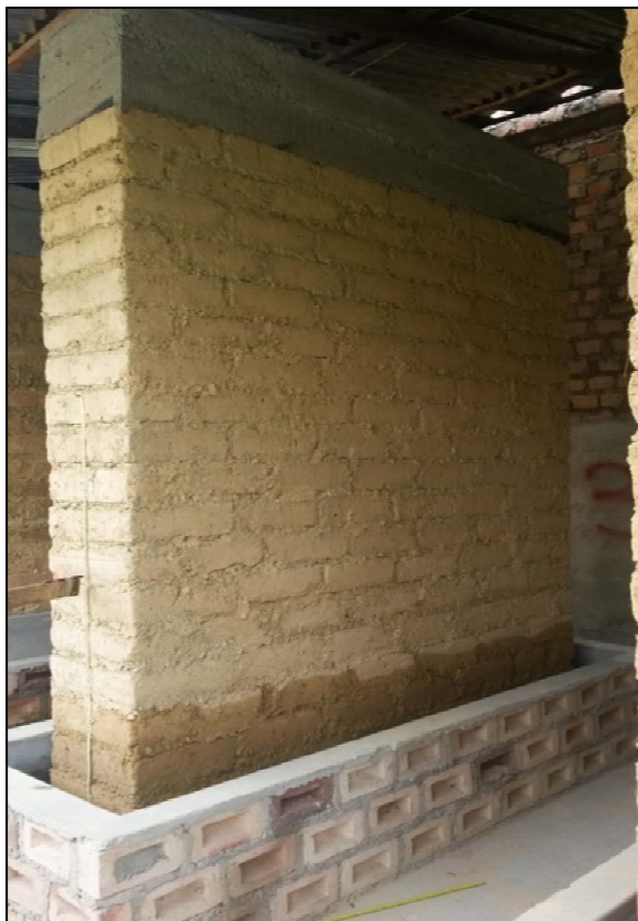
Figura N° 64: Muro ME al terminar el Periodo Corto de Inundación.
