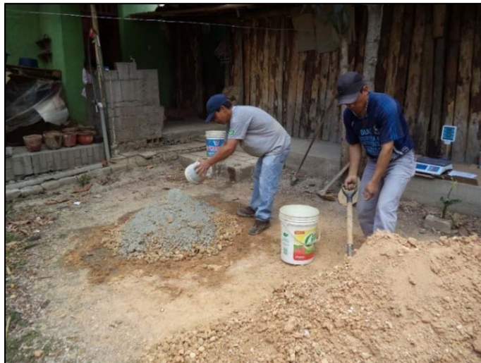
Figura N° 11: Dosificación y mezclado de material con cemento para la elaboración de adobes estabilizados.
