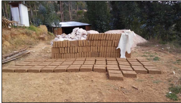
Figura N° 2: Adobes en proceso de secado y apilados para su uso.
