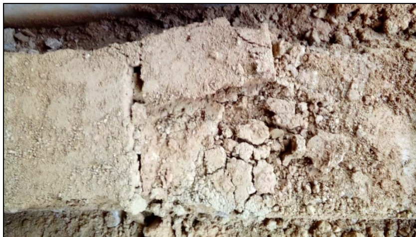
Figura N° 90: Junta entre la Hilera N° 02 y 03 del muro estabilizado ME.
