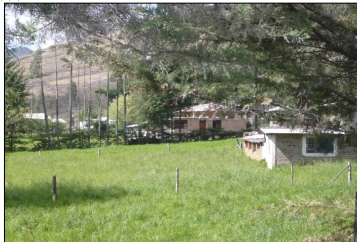
Fig. 31. Viviendas construidas con material noble.
