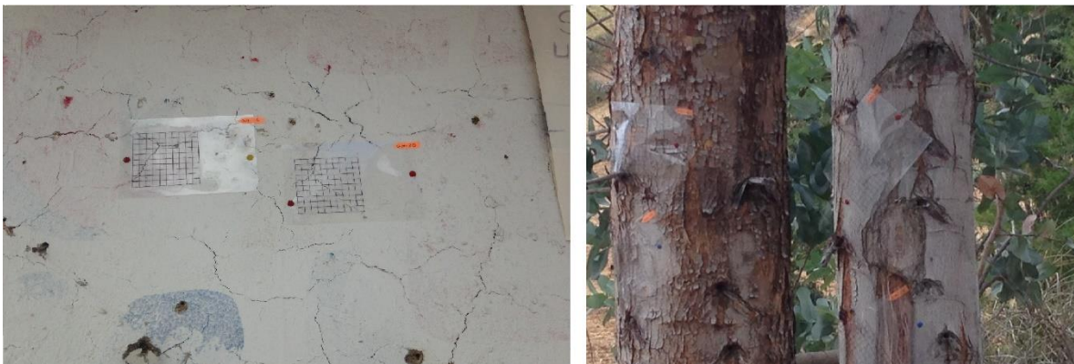
Fig. 36. Instalación de placas receptoras
