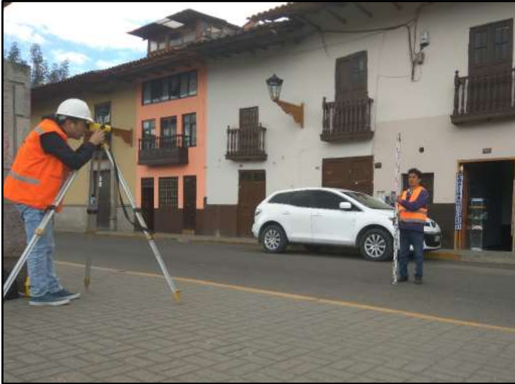
Fotografía N° 01: Se observa la toma de datos en la nivelación del eje de la vía
