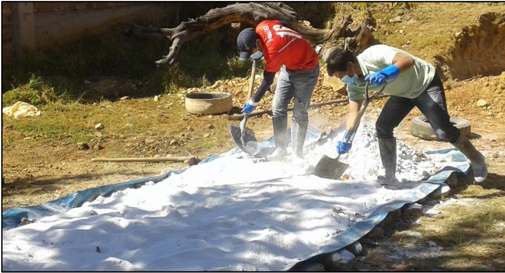
Foto 32 : Mezcla de cal apagada y suelo seco .
