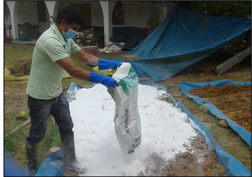
Foto 31 : Puesta de cal apagada en suelo seco, para adobes estabilizados tipo B, C y D.
