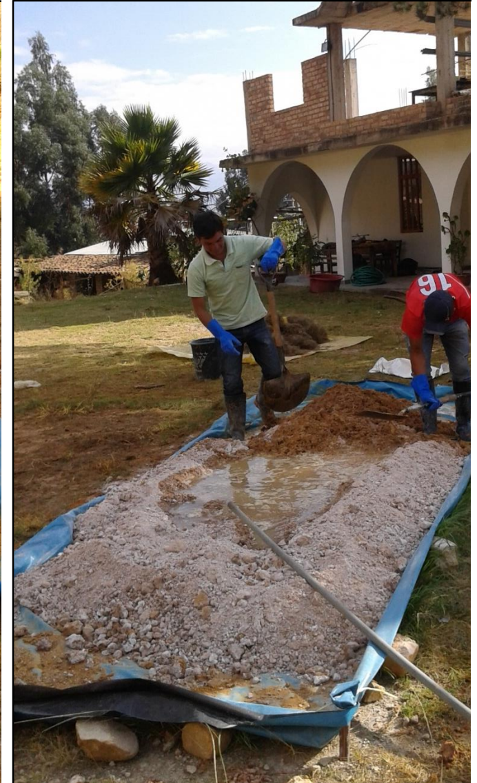
Foto 36 : Mezclado con palas de la cal apagada, suelo seco y agua a cargo de personal.
