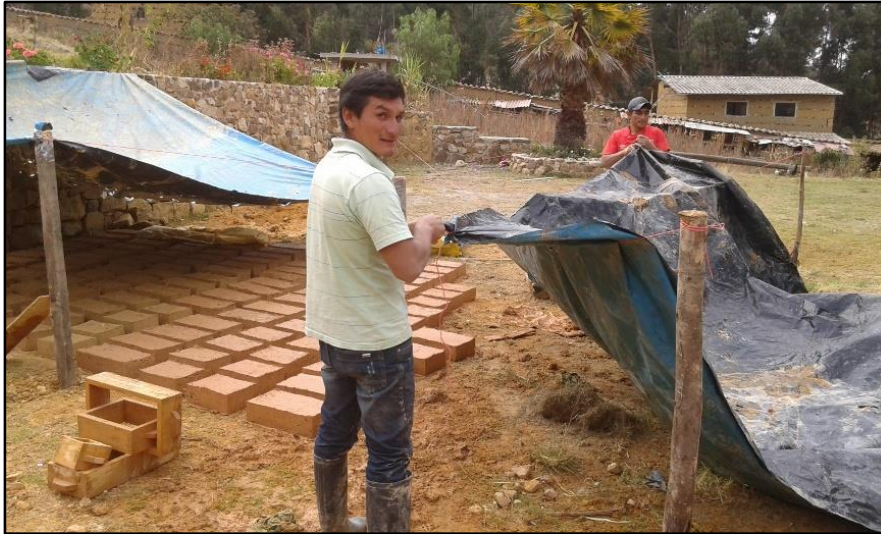
Foto 44 : Protección de adobes contra el viento y lluvia con toldos de plástico.
