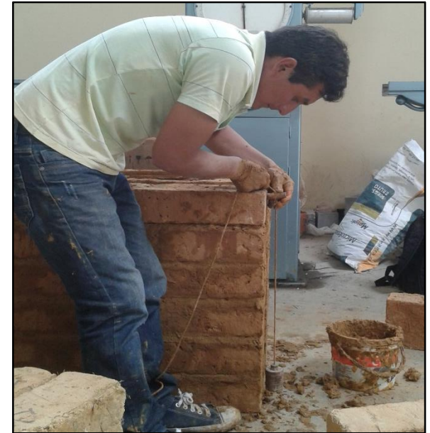
Foto 65 : Verificación de verticalidad con plomada de muretes de adobe.
