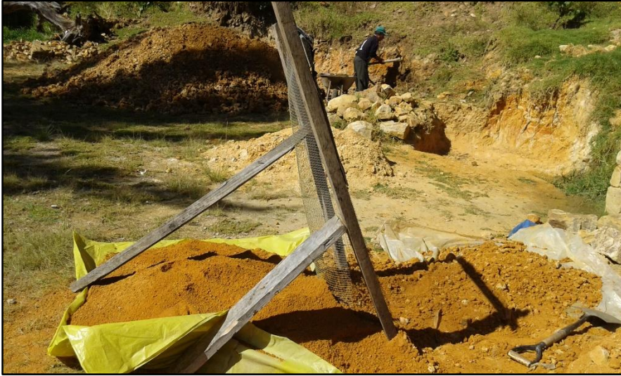
Foto 9 : Cernimiento del suelo para separar partículas de mayor tamaño.
