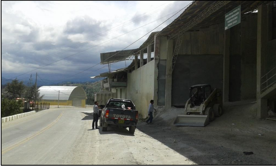
Foto 1 : Ubicación de la Empresa Minera El Progreso S.R.L., carretera 3N distrito de Bambamarca-Hualgayoc
