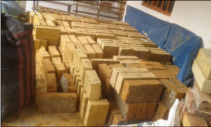
Foto 56 : Pilado de adobes, para protección bajo techo por inicio de lluvias.
