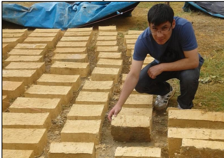
Foto 54 : Desplante de adobes para muretes después del proceso de secado.
