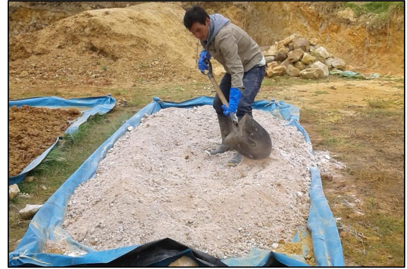
Foto 33 : Mezcla homogénea de suelo seco y cal apagada
