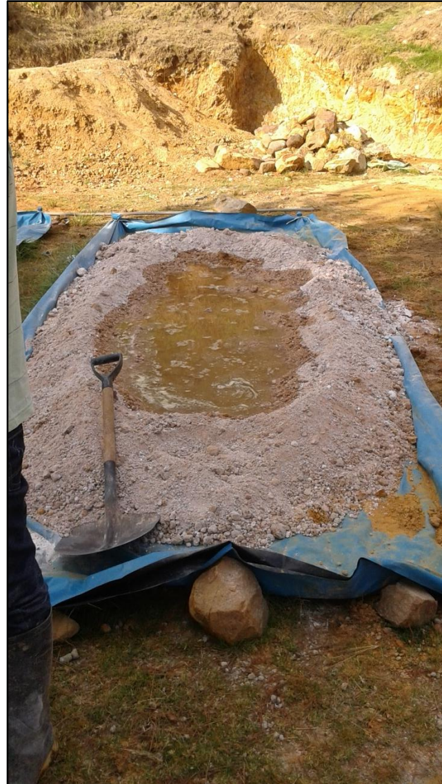
Foto 35 : Torta de cal apagada, suelo seco y agua
