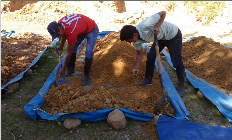
Foto 27 : Espolvoreo de la tierra, y extracción de partículas grandes .
