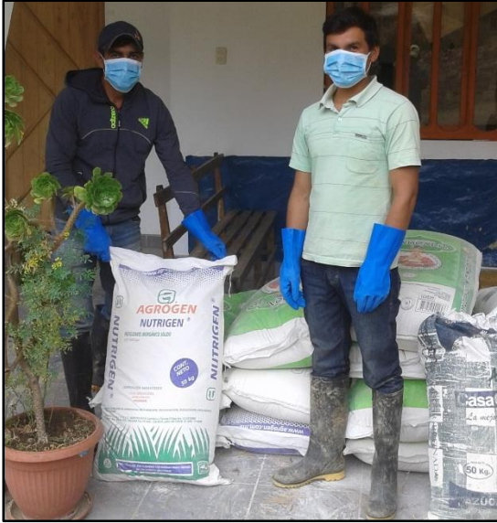
Foto 29 : Equipo de protección para manipular la cal apagada, botas de jebes, guantes para concreto, mascarilla.
