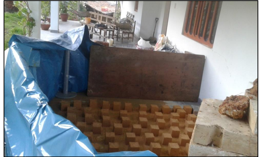
Foto 21 : Protección de unidades de adobe (cubos), contra el sol y el viento.
