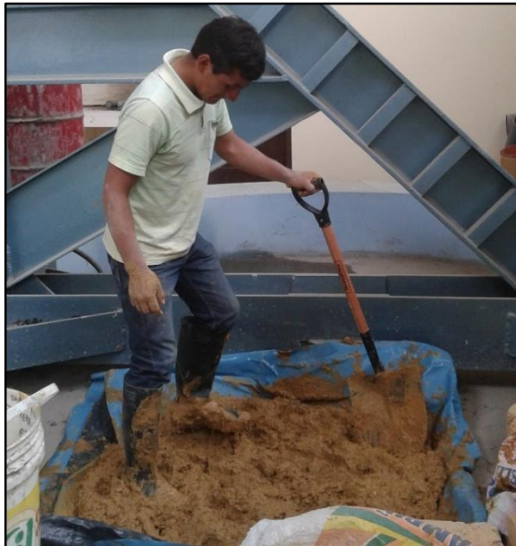
Foto 63 : Elaboración de mortero para pilas y muretes con las mismas características de cada tipo de adobe.
