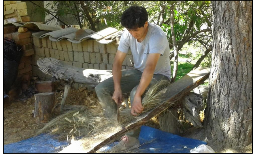
Foto 10 : Corte de paja ichu, longitud de 3 cm a 6 cm.
