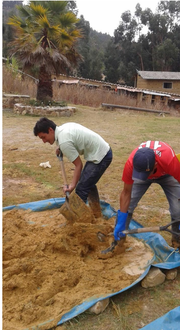
Foto 38 : Mezcla del barro con palas para homogenizar más la mezcla.
