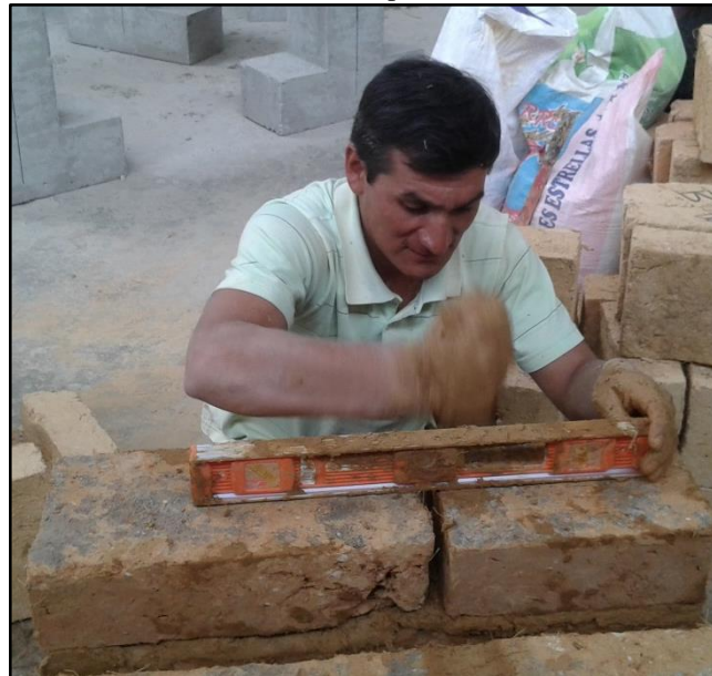
Foto 64 : Verificación de horizontalidad con nivel de mano de muretes de adobe.
