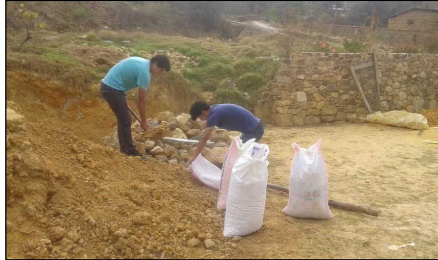
Foto 57 : Suelo tomado de cantera adobera Cruz Blanca para elaboración de morteros para pilas y muretes.
