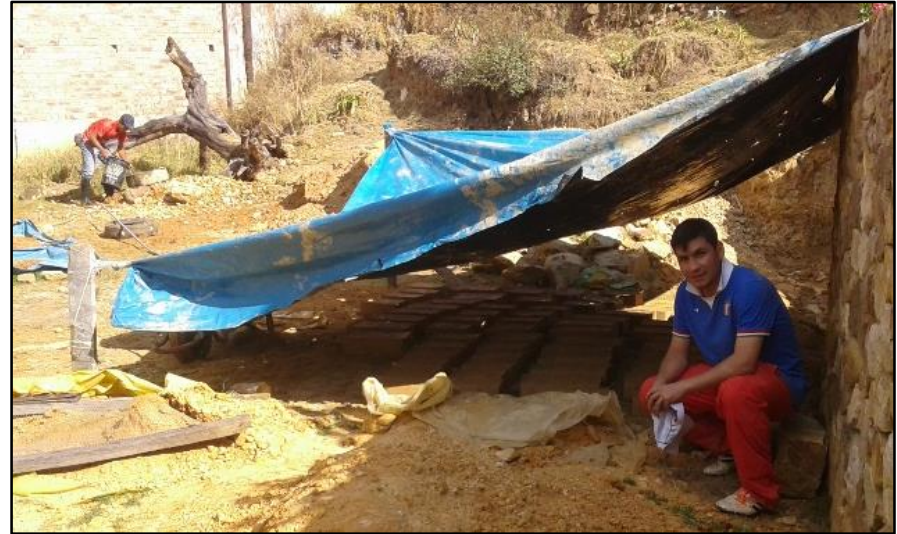
Foto 45 : Protección de adobes contra el viento y lluvia con toldos de plástico.
