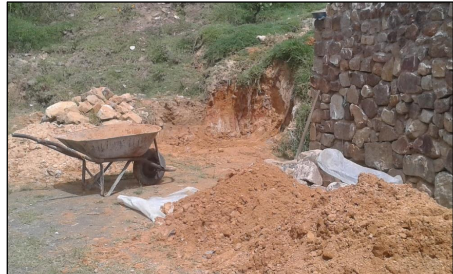
Foto 8 : Extracción de suelo de la cantera adobera Cruz Blanca para elaboración de adobes.
