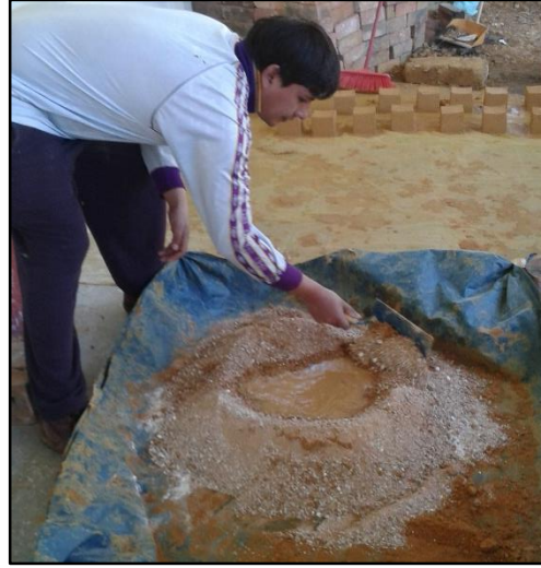
Foto 15 : Mezcla homogénea de cal apagada, suelo seco y agua.
