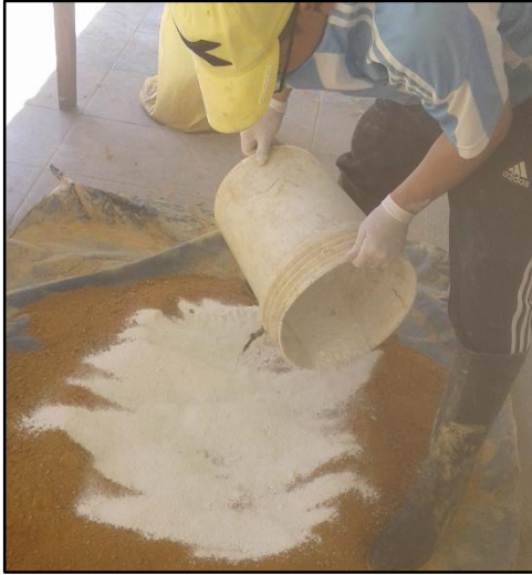
Foto 14 : Mezcla de la cal apagada con el suelo seco.
