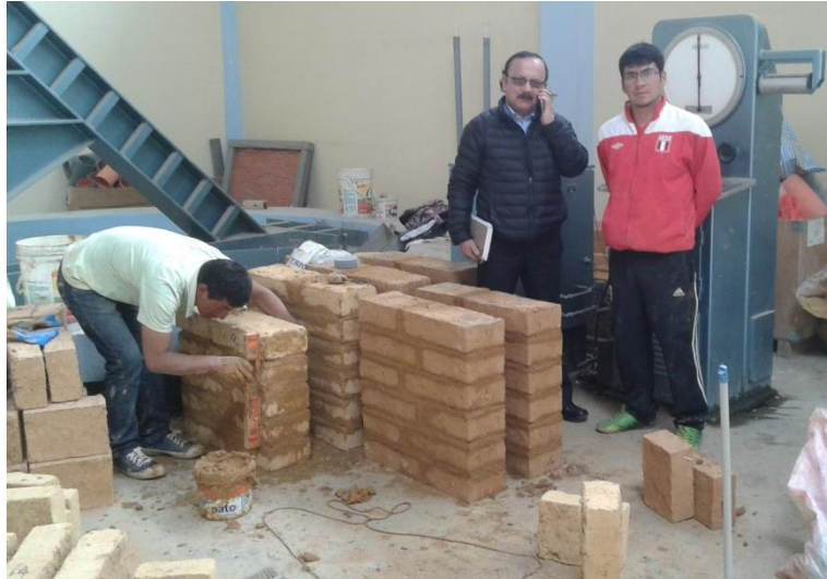
Foto 66 : Mg. Ing. Héctor Pérez junto a tesista y a maestro supervisando la adecuada elaboración de muretes de adobe.
