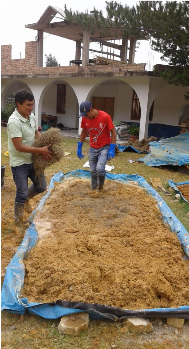
Foto 37 : Paja ichu añadida homogéneamente a lo largo de la mezcla, batido de barro.
