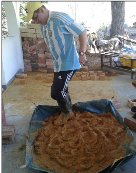
Foto 17 Batido de barro para elaboración de unidades de adobe (cubos)
