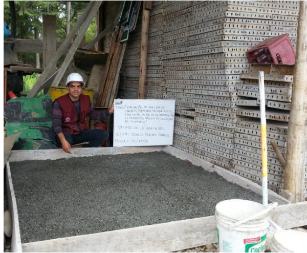
Fotografía 16. Losa de concreto permeable.
