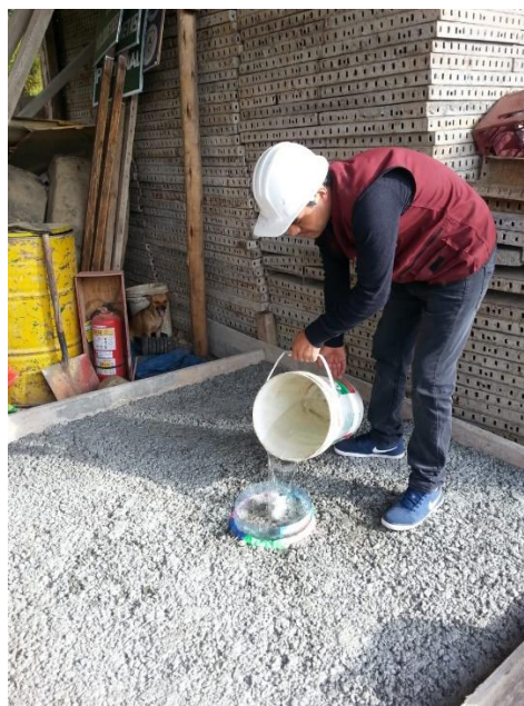
Fotografía 18. Prueba estándar para medir la tasa de infiltración en la losa.
