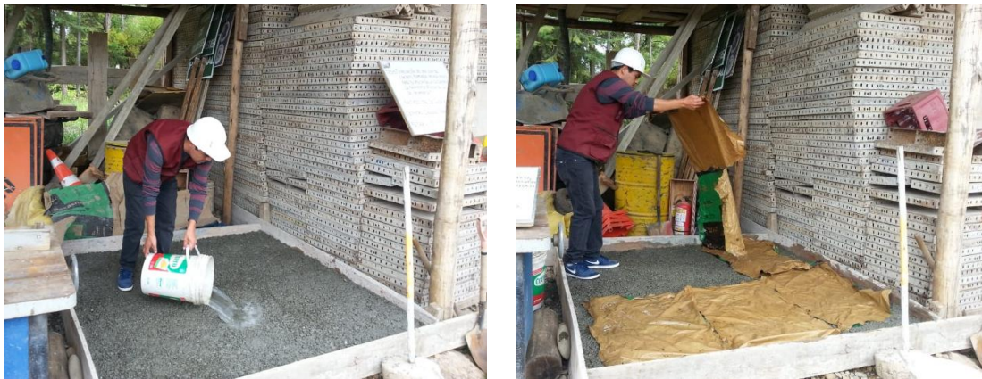
Fotografía 17. Curado de Losa de concreto permeable.
