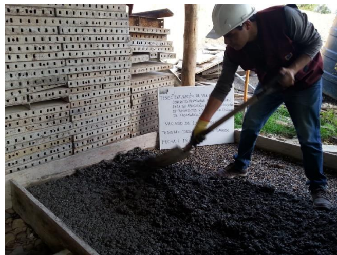
Fotografía 15. Vaciado del concreto permeable en la losa.
