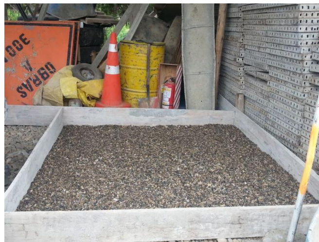
Fotografía 14. Sub base granular de la losa de concreto permeable.
