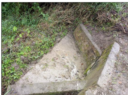
Foto 03: Alcantarilla TMC Ø12" cabezal de salida en buen estado y funcional (prog. 0+370 km)
