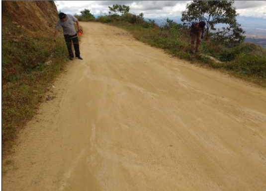
Foto 49: aliviadero TMC Ø 36", en regular estado y funcional (prog. 06+490 km).
