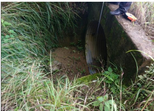
Foto 29: Cabezal de entrada de aliviadero TMC Ø 36", en regular estado y funcional (prog. 03+975 km).
