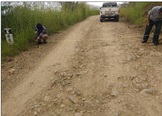
Foto 21: Kilómetro (03+000 km) de la carretera vecinal. Hito Kilométrico
