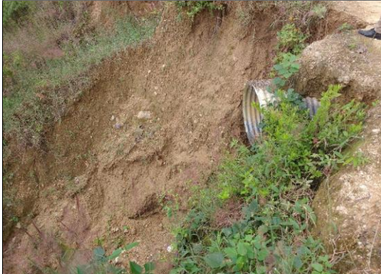
Foto 55: Sin cabezal de salida de alcantarilla TMC Ø 36" y funcionando (prog. 06+600 km).
