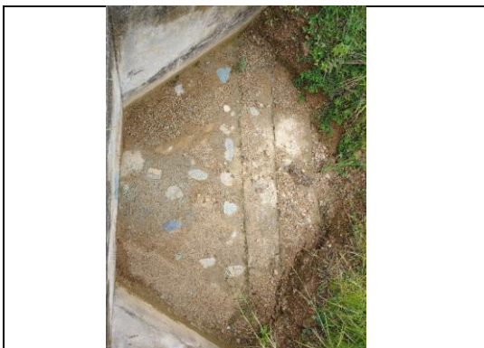
Foto 23: Cabezal de salida de alcantarilla TMC Ø 36", en regular estado y funcional (prog. 03+010 km).
