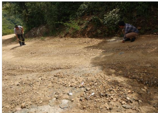
Foto 16: Baden de concreto (6.00x6.00 m) en regular estado y semicolmatado (prog. 1+745 km)
