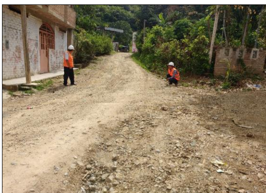
Foto 01: Kilómetro de inicio (00+000 km) de la carretera vecinal, Sector Magllanal.
