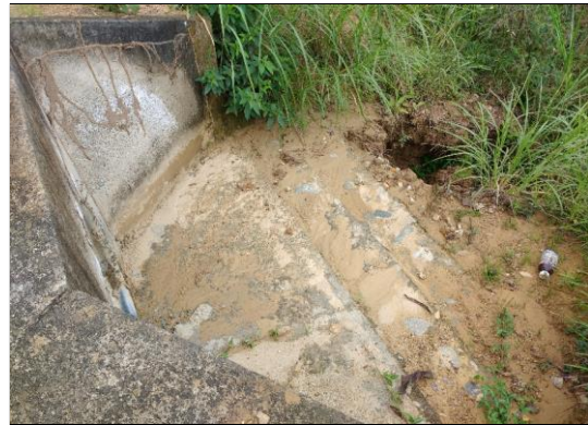
Foto 46: Cabezal de salida de aliviadero TMC Ø 36", en regular estado y funcional (prog. 05+970 km).
