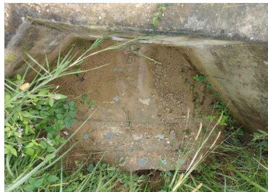
Foto 36: Cabezal de salida de aliviadero TMC Ø 36", en regular estado y funcional (prog. 04+545 km).
