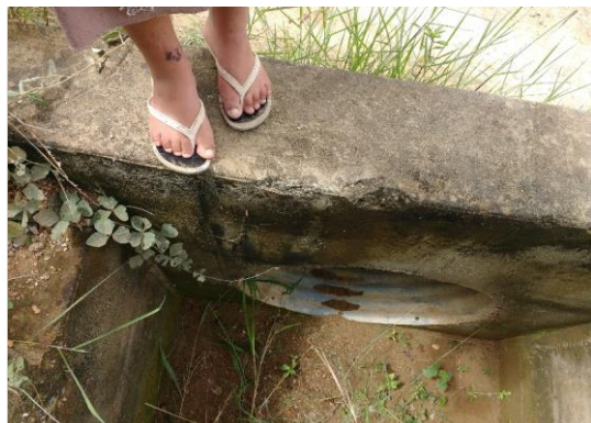
Foto 18: Cabezal de entrada de aliviadero TMC Ø 36", en regular estado y funcional (prog. 2+045 km).
