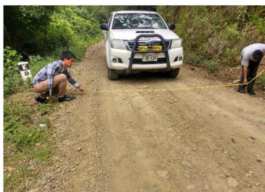
Foto 06: Kilómetro (01+000 km) de la carretera vecinal. Hito Kilométrico.
