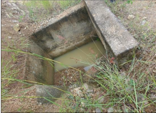
Foto 25: Cabezal de entrada de aliviadero TMC Ø 36", en regular estado y funcional (prog. 03+125 km).
