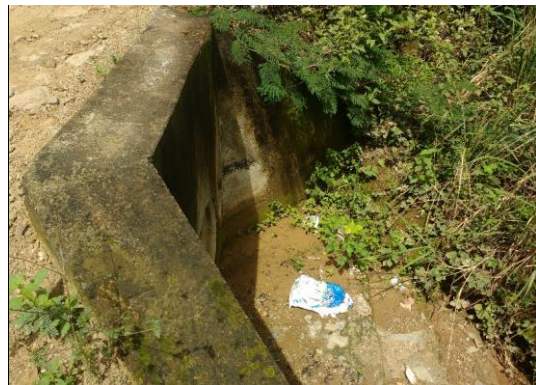
Foto 12: Cabezal de salida de alcantarilla TMC Ø 36", en regular estado y funcional (prog. 1+150 km)
