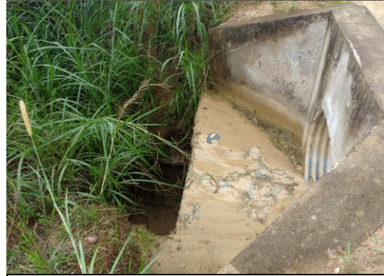
Foto 44: Cabezal de salida de aliviadero TMC Ø 36", en regular estado y funcional (prog. 05+840 km).
