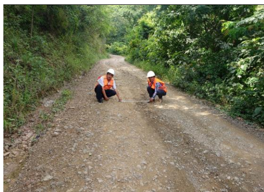
Foto 02: Medición de la erosión (prog. 0+090 km).
