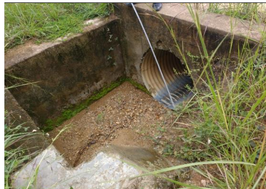
Foto 22: Cabezal de entrada de alcantarilla TMC Ø 36", en regular estado y funcional (prog. 03+010 km).
