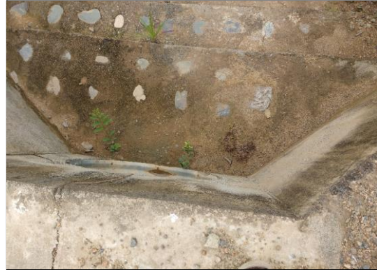
Foto 26: Cabezal de salida de aliviadero TMC Ø 36", en regular estado y funcional (prog. 03+125 km).
