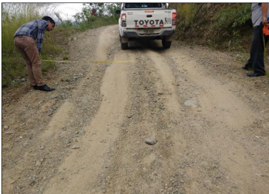
Foto 39: Kilómetro (05+000 km) de la carretera vecinal. Sin hito Kilométrico
