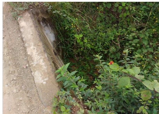
Foto 30: Cabezal de salida de aliviadero TMC Ø 36", en regular estado y funcional (prog. 03+975 km).
