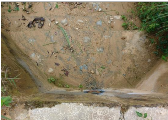
Foto 51: Cabezal de salida de aliviadero TMC Ø 36", en regular estado y funcional (prog. 06+490 km).
