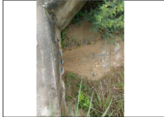
Foto 38: Cabezal de salida de aliviadero TMC Ø 36", en regular estado y funcional (prog. 04+935 km).
