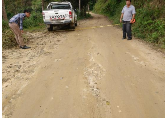
Foto 56: Kilómetro (07+000 km) de la carretera vecinal. Sin hito Kilométrico
