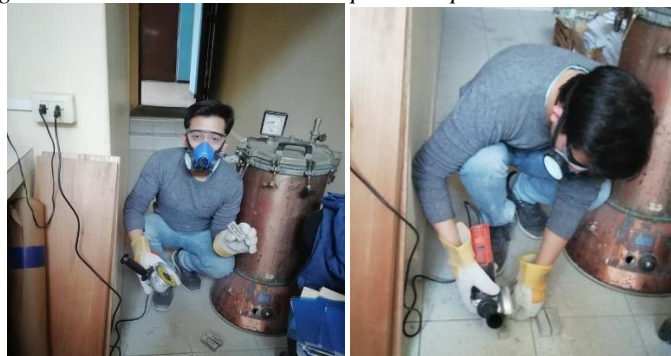
Figura 120: Proceso de fisuramiento de las probetas prismáticas de concreto con y sin aditivo bacteriano incorporado.
