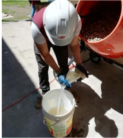
Figura 145: Incorporación de aditivo bacteriano al agua de mezcla.
