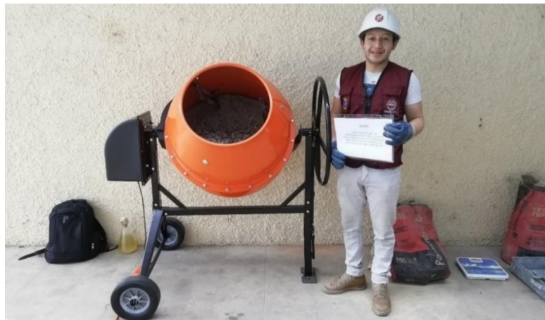
Figura 143: Mezclado de los materiales en trompo mezclador.
