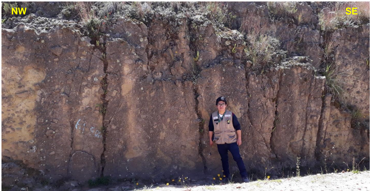
Foto 5. Fracturamiento irregular formadas por enfriamiento rápido. Carretera al centro Poblado de Tual – Cajamarca.
