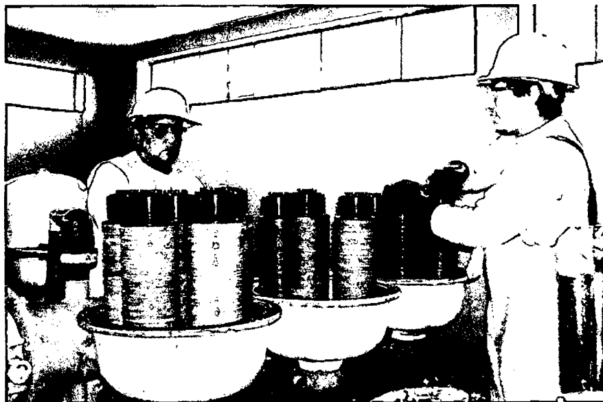
Foto 42. Vista de los filtros después de su limpieza con agua a presión.
