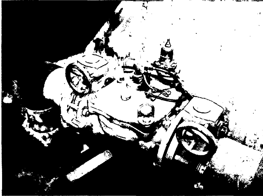
Foto 35. Cámaras de riego, a donde llega la señal de mando electrónica del riego y activa las válvulas para el riego en campo.
