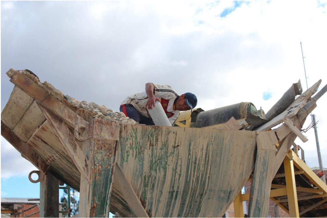
FOTO N° 3: Triturando el material reciclado en la Planta de chancado Acosta.
