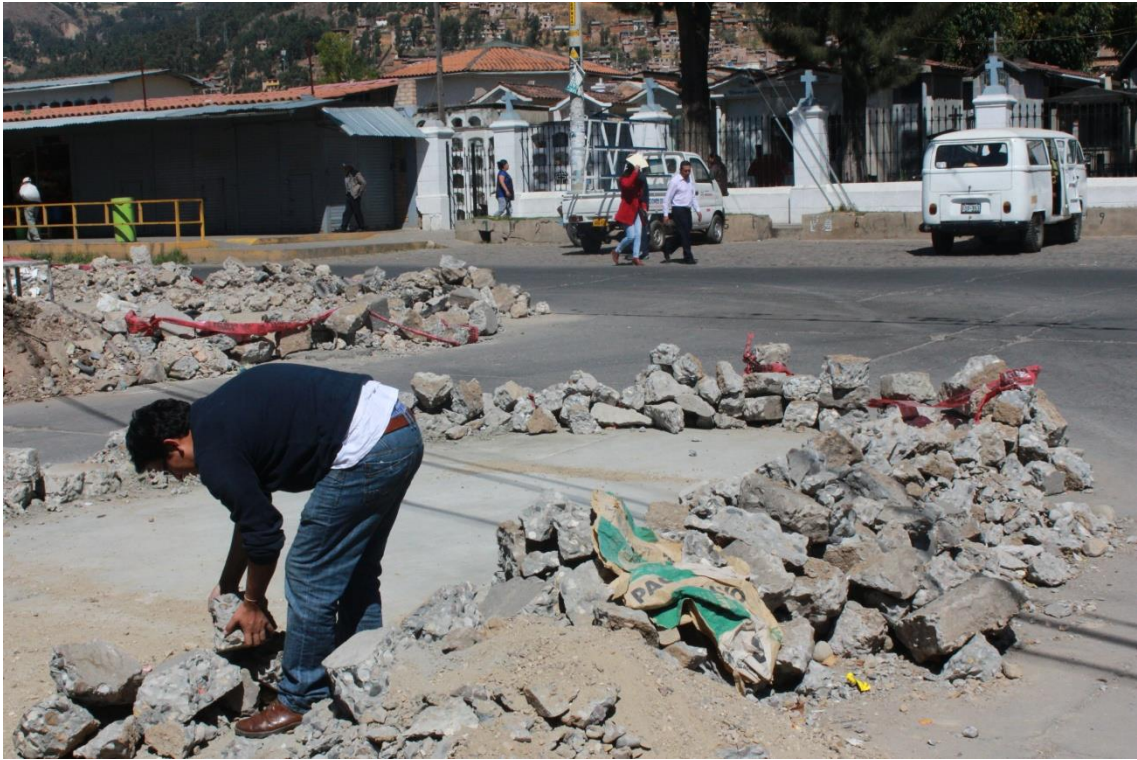
FOTO N° 1: Reciclando material de concreto.
