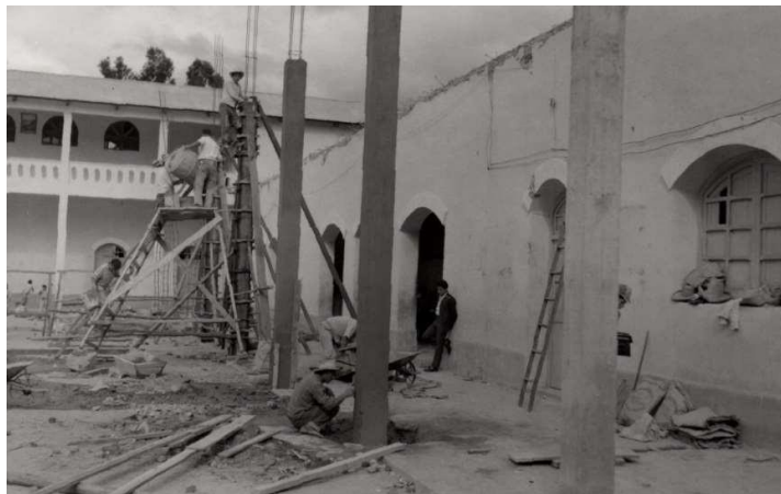
Figura 45. Construcción de columnas enfrente del Pabellón C en 1963. Fuente: Archivo fotográfico ISEP “Hno. Victorino Elorz Goicoechea”.
