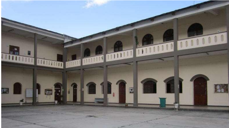
Figura 40. Balcones soportados por columnas de concreto armado.
