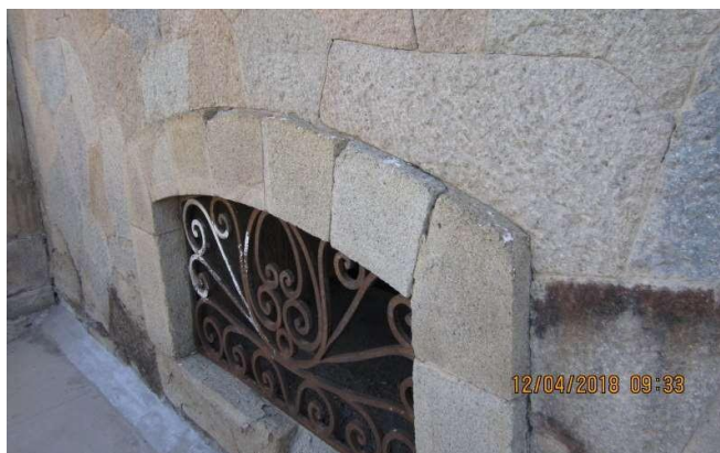
Figura 46. Muro de piedra andesita del Pabellón D por debajo del nivel del patio principal.
