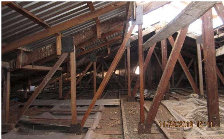
Figura 41. Estructura de madera del techo del auditorio.
