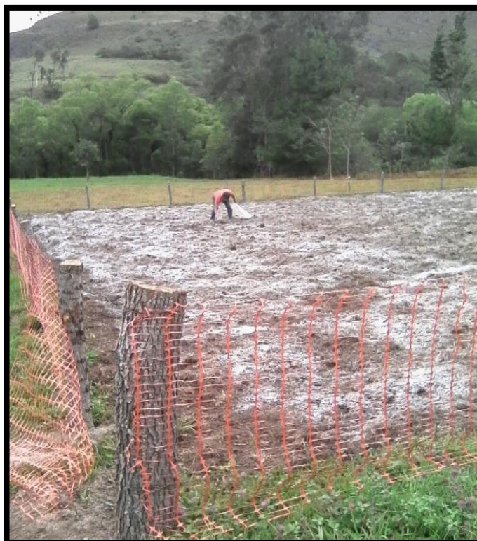
IMAGEN 07: Vista lateral y colocado de cal
