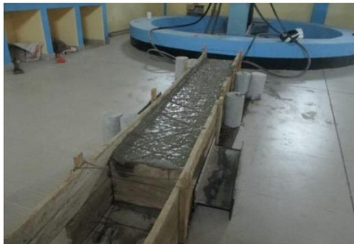
**Figura 12.** Encofrado y vaciado de concreto en cimentación
