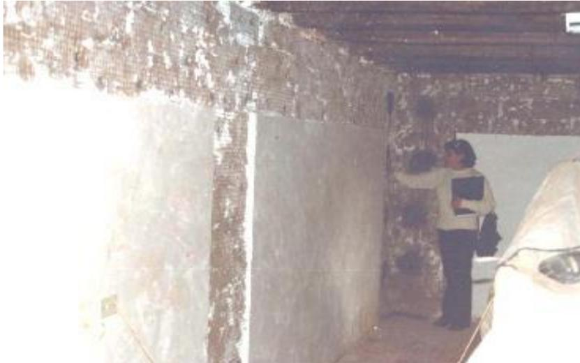
**Figura 4:** Perforaciones @ 50cm. para reforzar muros con Malla Electrosoldada
