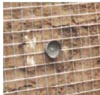
**Figura 7:** Doble del conector y fijación con 2 clavos y lata.
