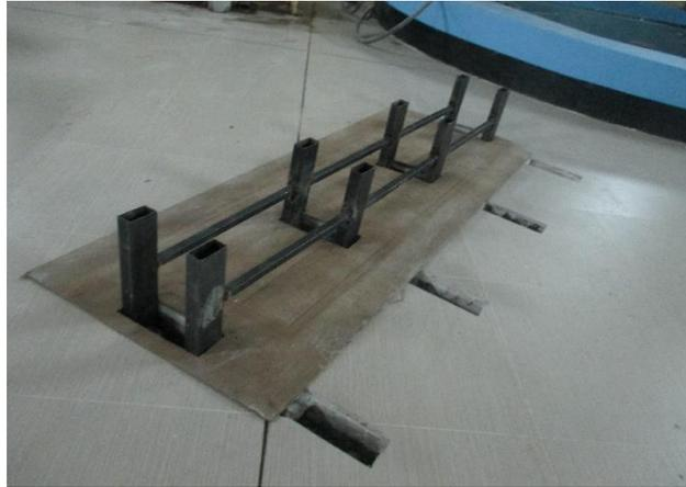
**Figura 11.** Anclajes para fijación de cimentación
