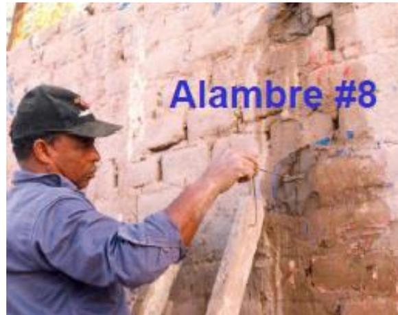
4. Instalación de la malla fijándola con chapas (Fig. 24) o retazos de madera o lata, clavándola al muro @ 25cm. Se evitará la formación de bolsones. Luego se doblará el conector a 90° y se fijará al muro con chapas o retazos de lata o madera, clavándolo con doble clavo de 2 ½ pulgadas (figuras 25 y 26).
