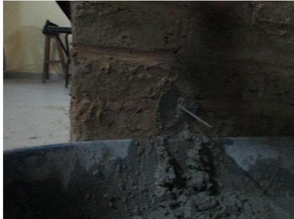
**Figura 16.** Instalación de conectores
