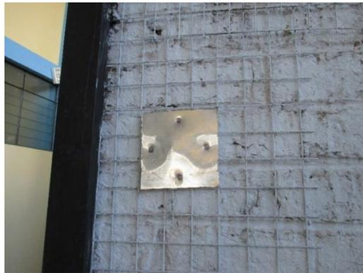
**Figura 19.** Fijación con lata.
