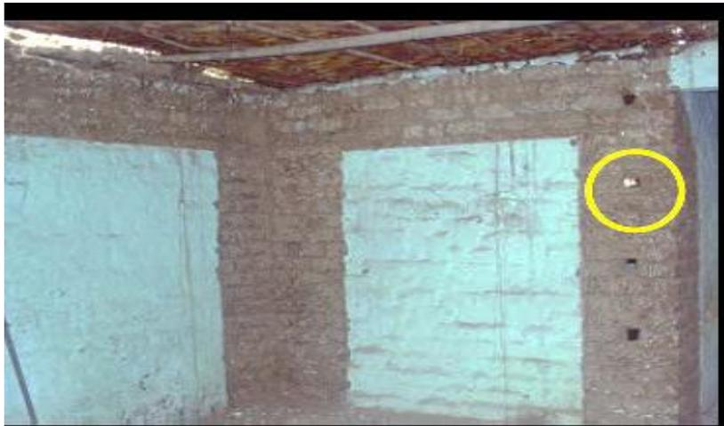
3. Instalar el conector y taponar la perforación con mortero 1:5 (Fig. 23).
