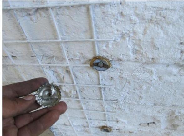
**Figura 18.** Fijación con chapas.
