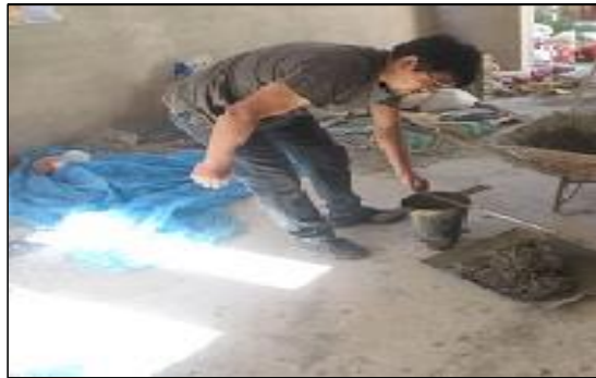
Imagen 10 Ensayo de Consistencia de la mezcla de concreto.
