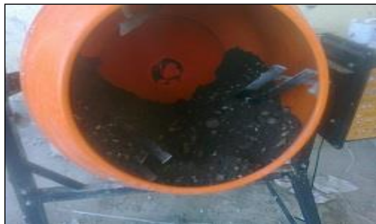
Imagen 08 Preparacion de mezcla de concreto para 3 tandas
