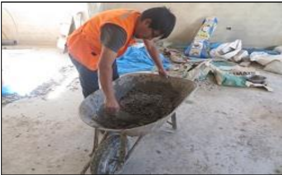
Imagen 09 Preparacion de mezcla de concreto para 3 tandas
