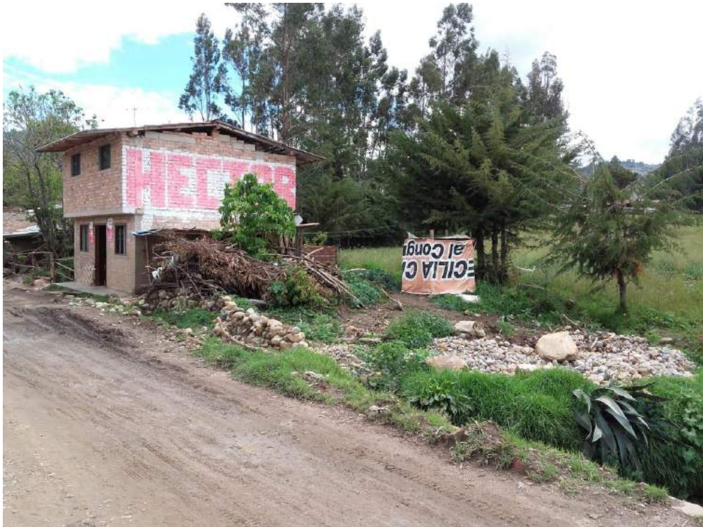
Figura N° 76: Zona de desborde de inundación del centro poblado La Quispa. Fuente: Fotografía Propia.
