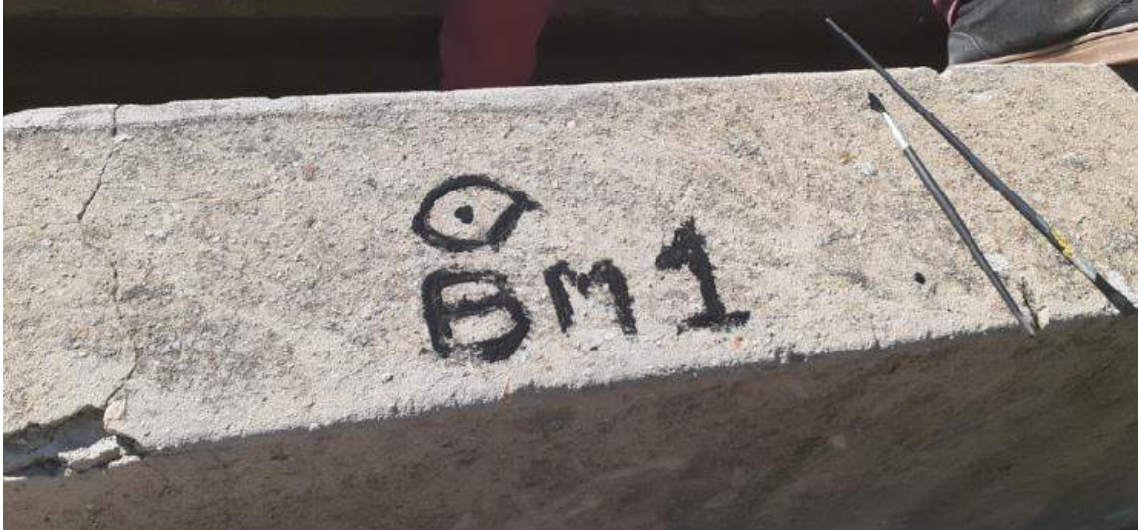
Figura N° 47: BM1 pintado en un puente canal que será nuestro punto base para el levantamiento topográfico.
