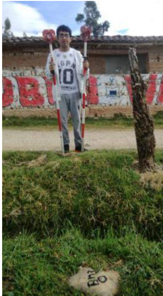
Figura N° 51: Jalones y primas para el levantamiento topográfico Fuente: Fotografía Propia
