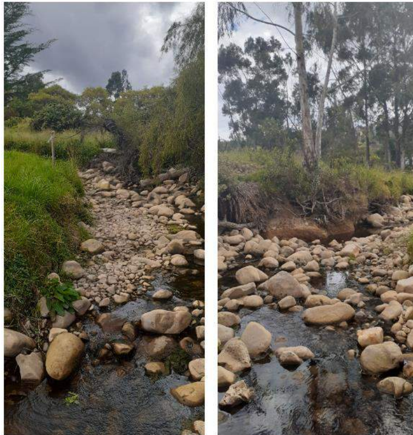
Figura N° 23: Río Quinuas, tramo de la zona de estudio Fuente: Fotografía Propia
