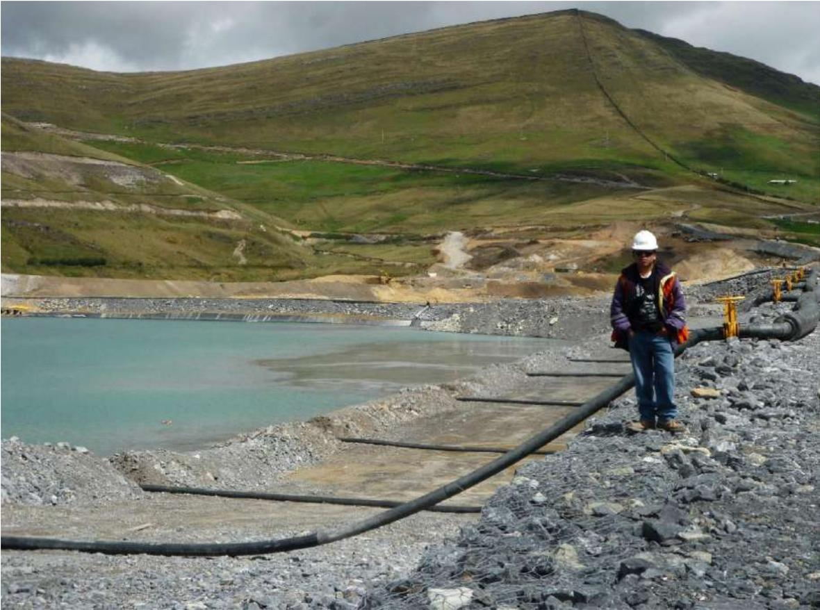
Fotografía N° 12: Levantamiento Topográfico complementario y evaluación de una posible ruta de disposición de relaves RST por el flanco derecho y zona norte de la presa de relaves.
