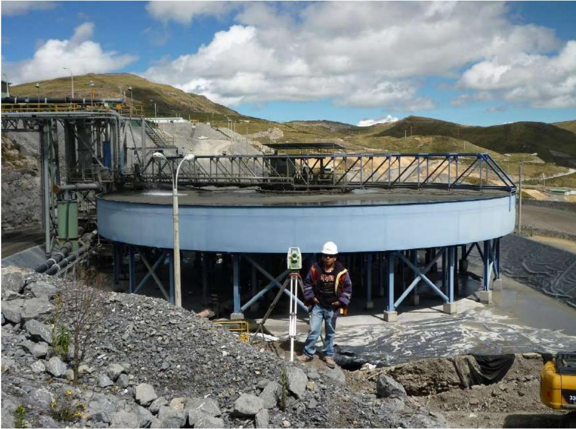
Fotografía N° 10: Levantamiento Topográfico de las líneas de disposición CST y RST.
