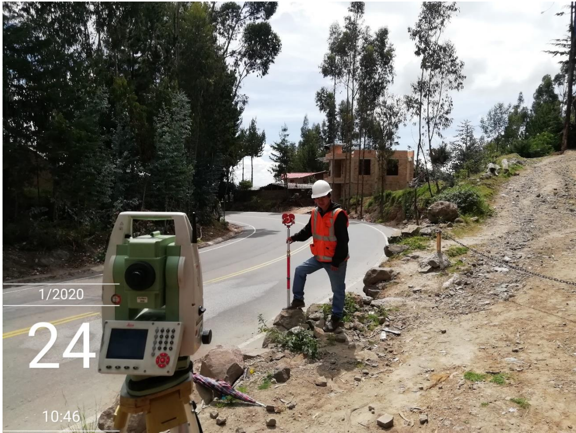
Fotografía N° 9: Toma de puntos de las cunetas existentes.
