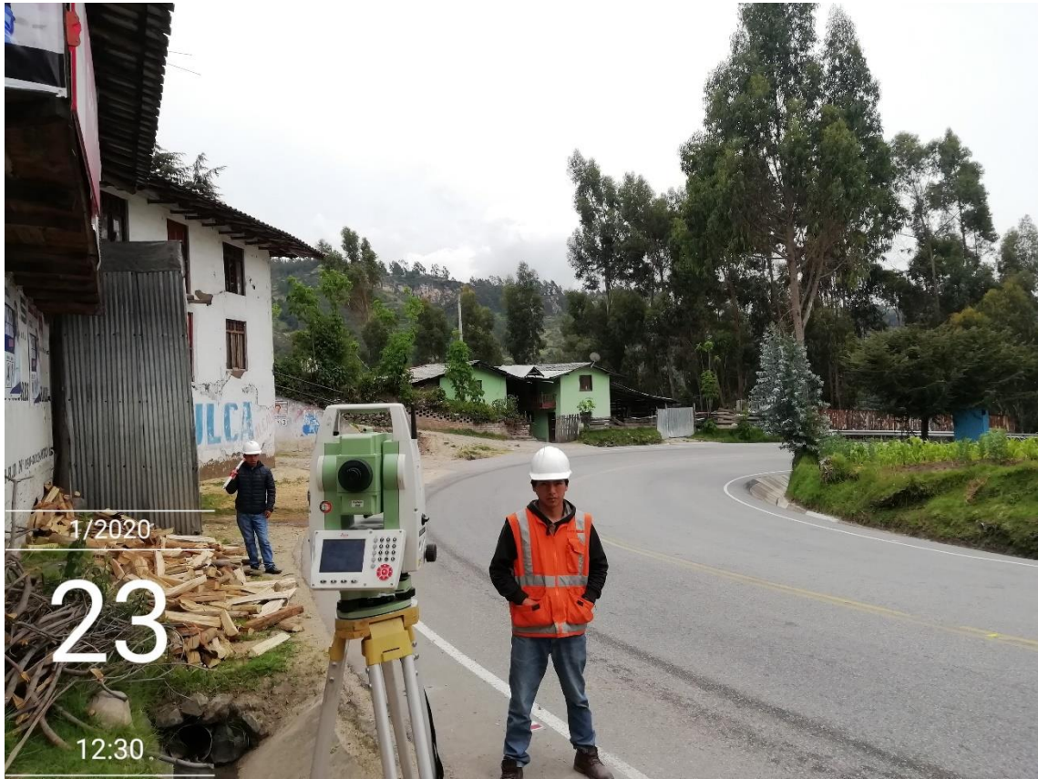
Fotografía N° 5: Levantamiento de curva de vuelta.
