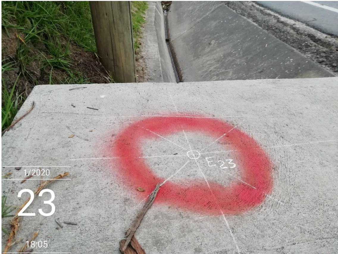
Fotografía N° 7: Marca de puntos de cambios de estación.
