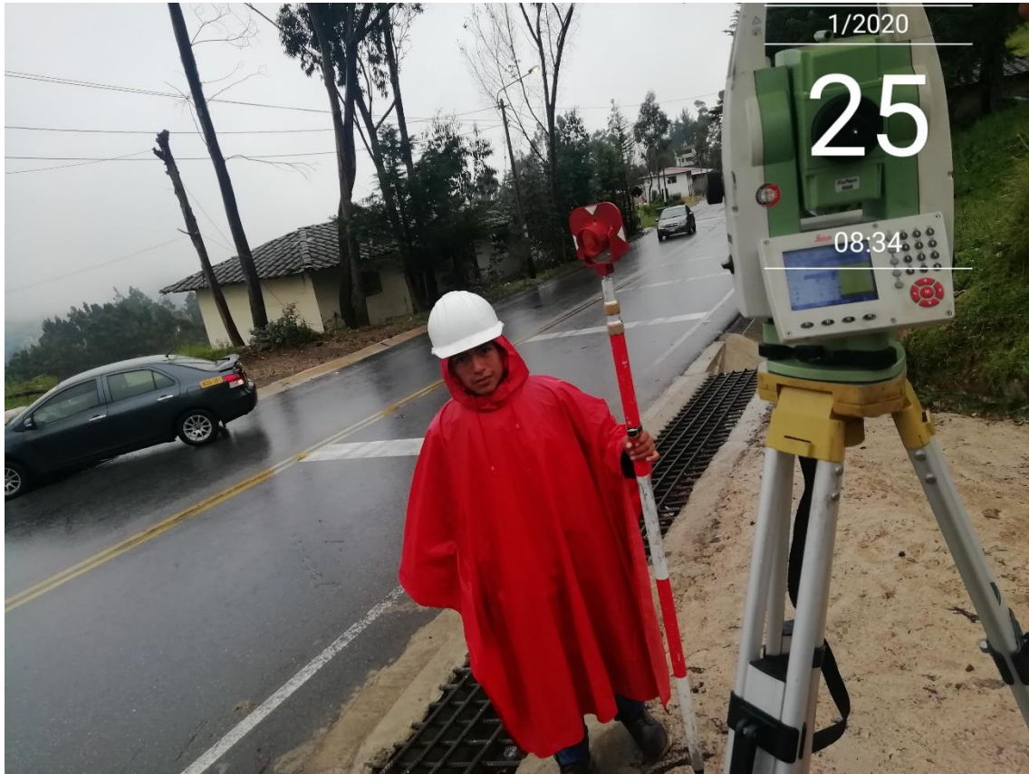
Fotografía N° 11: Levantamiento de tramos en curva.
