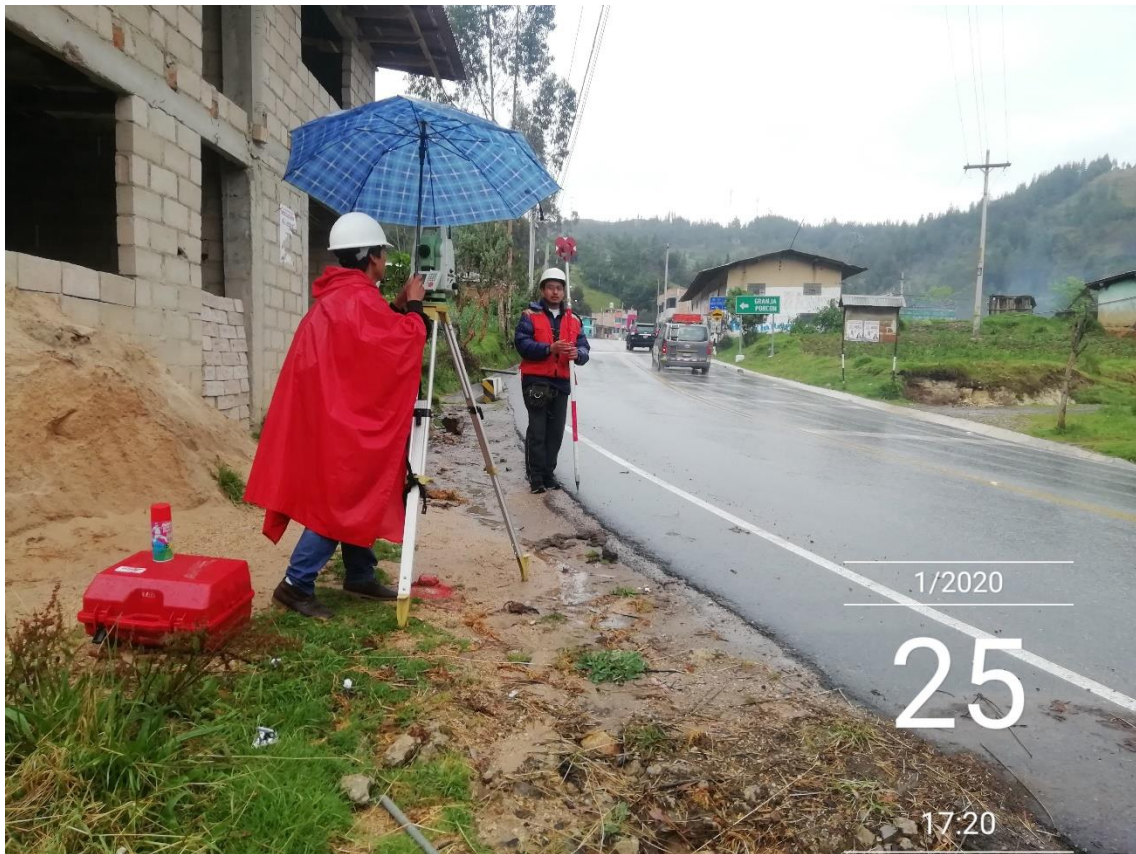
Fotografía N° 16: Toma de puntos de la berma.
