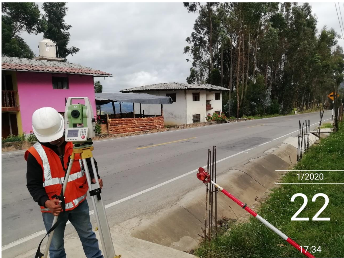
Fotografía N° 4: Cambio de estación.
