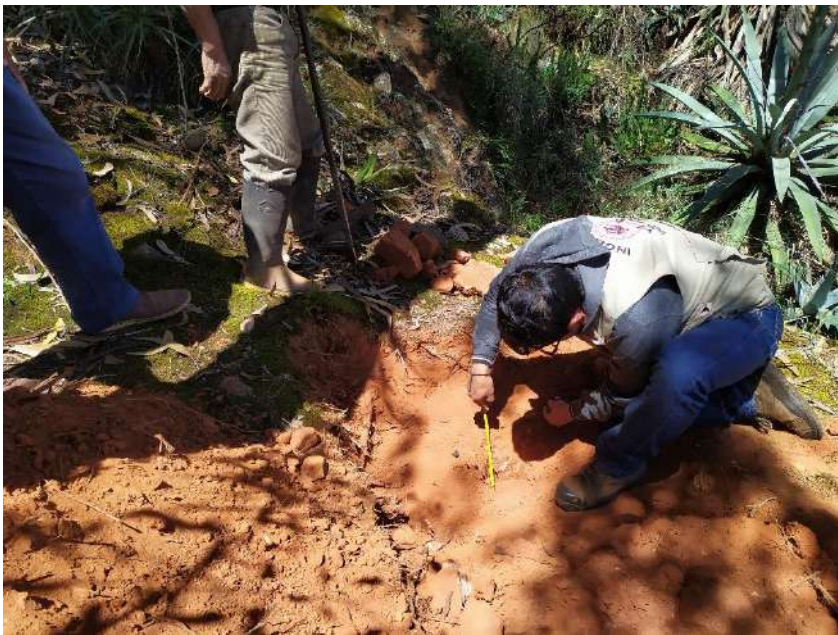
Foto 4. Fijando las medidas del hoyo excavado.
