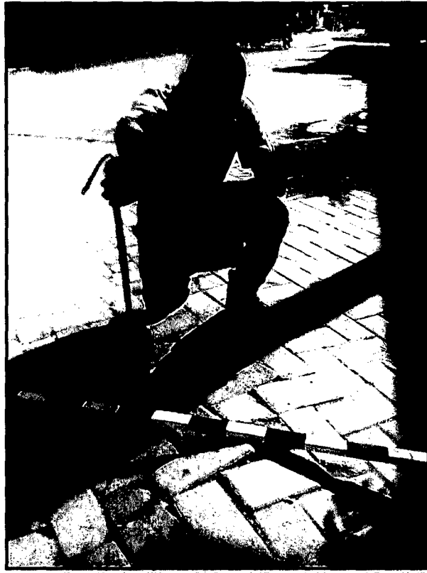
Figura 25. Abultamiento, BA. Área > 0.5m 2 . Severidad Alta. En la Calle Universidad.
