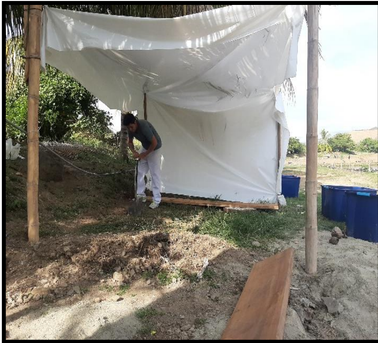
Fotografía N 3: Acondicionamiento del área e instalación de los estanques
