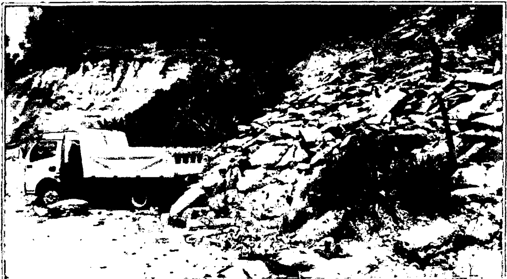
FOTO 7.2: Carguío del concreto reciclado al volquete de 4 m 3 , para ser llevado a la chancadora.
