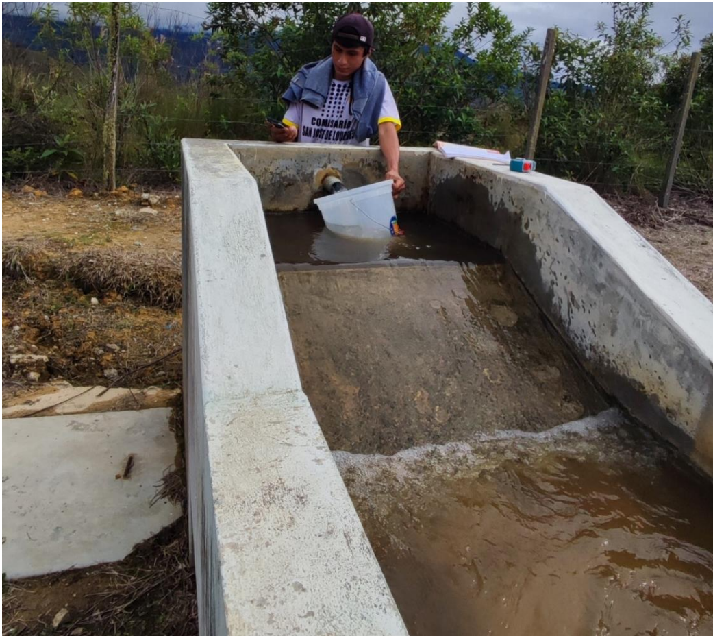
Foto 17: Aforo de caudales de llegada de las dos fuentes al PTAP.
