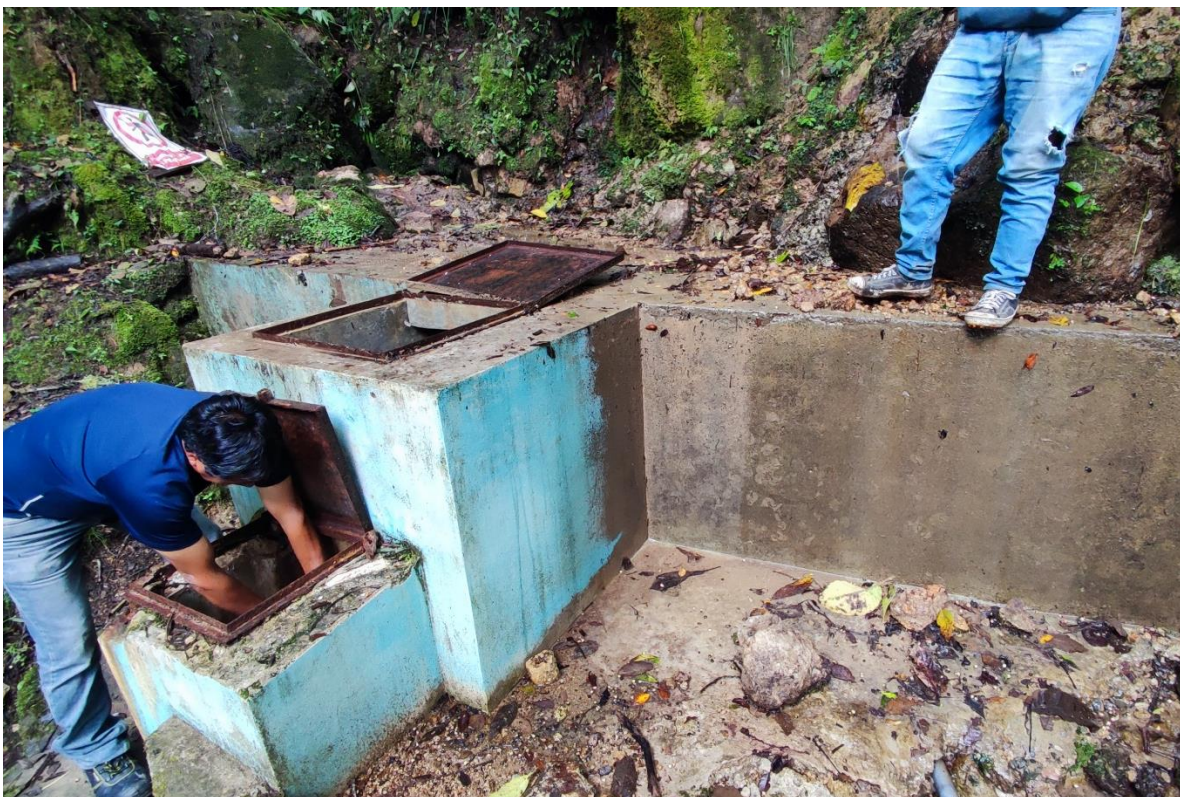
Foto 23: Dimensionamiento de la captación de manantial.
