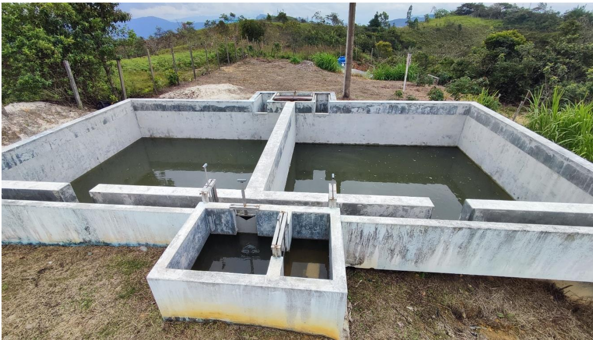
Foto 27: Filtro lento de la PTAP y cámara de reunión de caudales de la PTAP.
