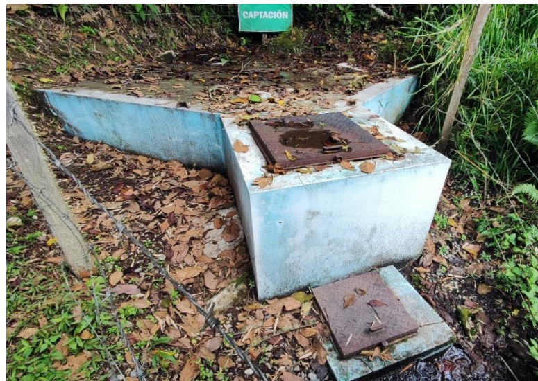
Foto 3: Captación N° 2 del cerro Llahuago.
