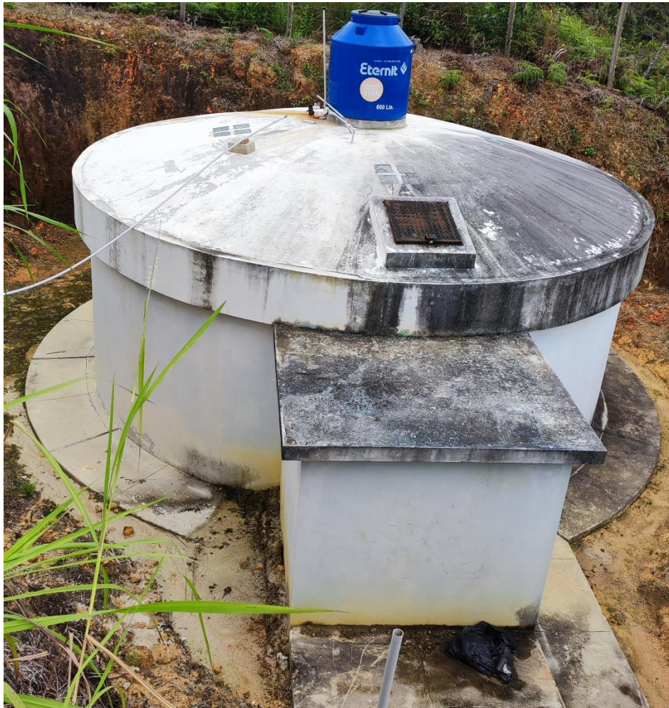
Foto 28: Reservorio circular del sistema.
