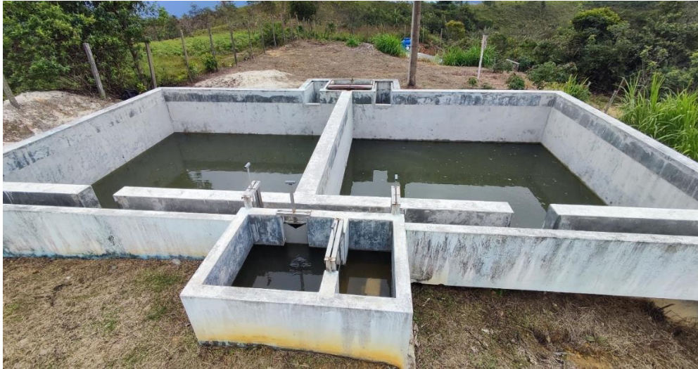
Foto 12: Filtro lento y cámara de reunión de la planta de tratamiento.
