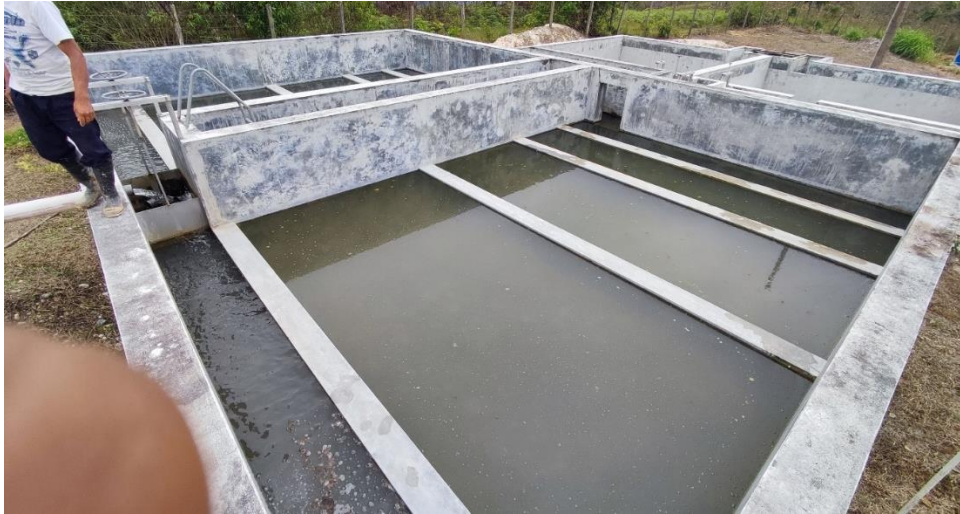
Foto 11: Pre filtro de la planta de tratamiento.
