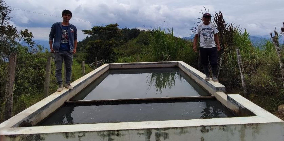
Foto 24: Inspección del desarenador.
