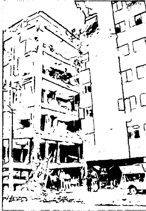
Figura 4. Daños producidos en un edificio de concreto armado en las columnas, muros de relleno (tabiques), vigas durante el sismo de México en 1985. Fuente: UNAM.
