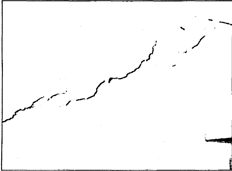
Fotografía 5.- Agrietamiento diagonal en pared.
