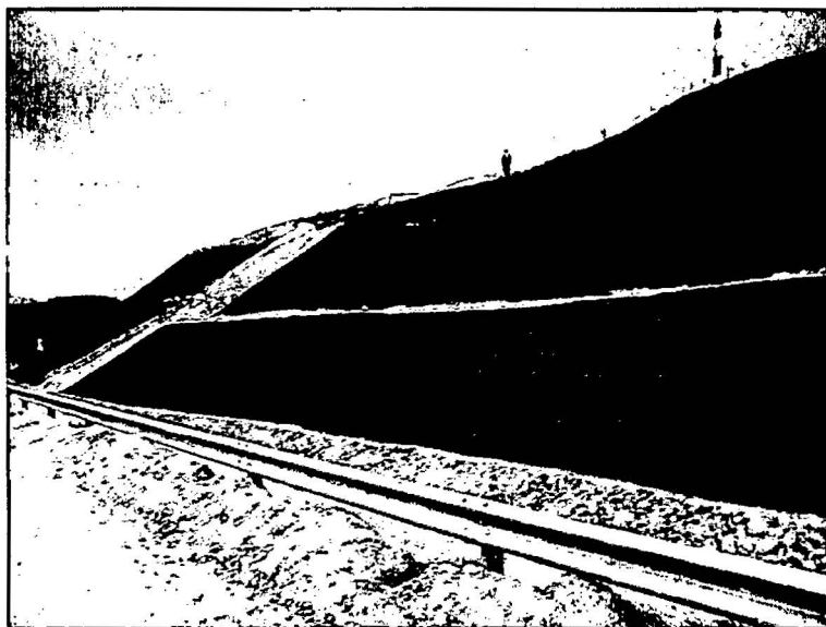
Talud Múltiple Rehabilitado utilizando Mantas
