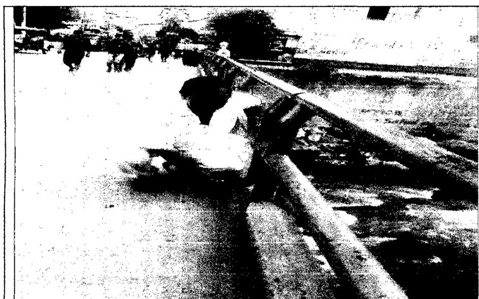
**FIGURA N° 04: SARDINEL DETERIORADO DEL PUENTE
