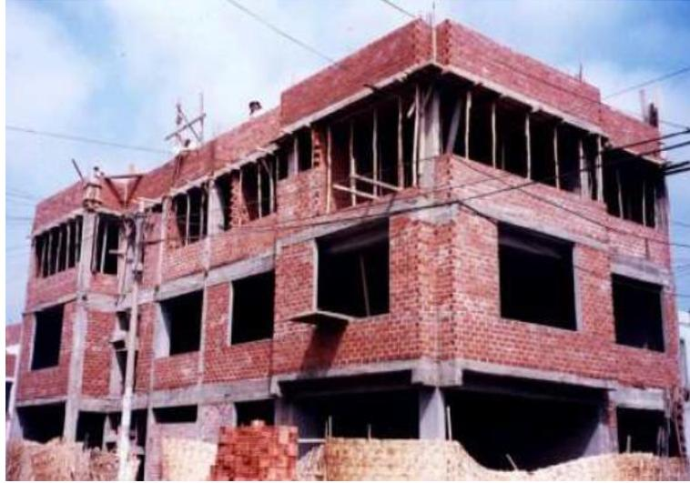
*Figura 2: Edificios de concreto armado con muros.
