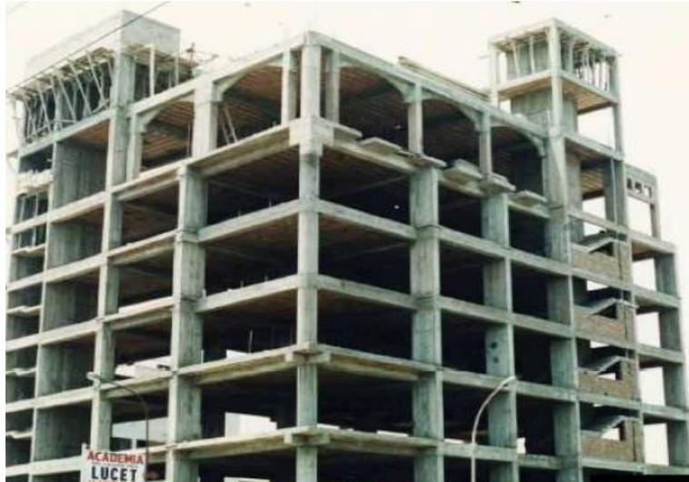
*Figura 3: Edificio aporricado de concreto armado.
