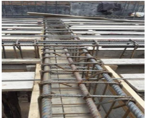
(d) Deficiente recubrimiento en vigas
