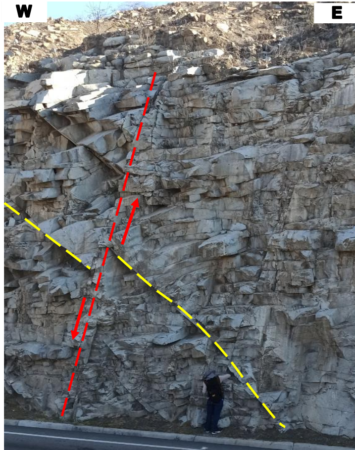
Foto 3.16: Fallas conjugadas en macizo granodiorítico altamente fracturado Aparente Falla Normal: Az=N 185°, Buz=39°NW. Coordenadas: E 696864; N 9199854; Cota = 386 m.s.n.m.
