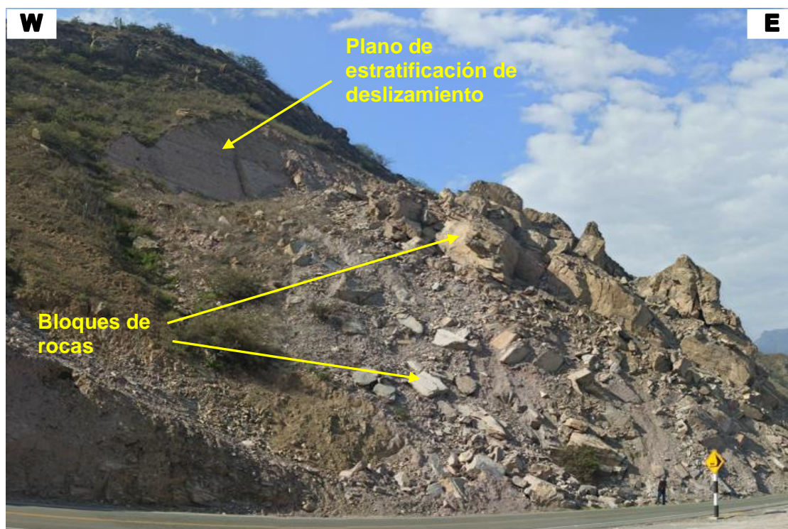
Foto 3.24: Deslizamiento de rocas calizas con rotura planar, entre el Km.41+142 y Km. 41+217 de la carretera Ciudad de Dios - Cajamarca. Coordenadas: E 700418; N 9201390; Cota= 435 m.s.n.m.
