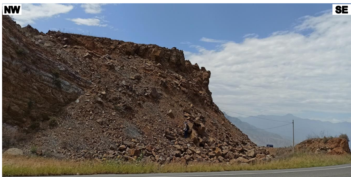
Foto 3.23: Deslizamiento de rocas tipo traslacional planar, cubriendo la vía antigua entre las progresivas km.37+224 al Km. 37+364 de la carretera Cajamarca – Ciudad de Dios. Coordenadas: E 698195; N 9201139; Cota= 427 m.s.n.m.
