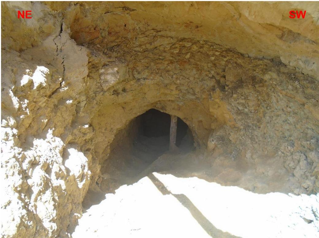
Foto 8. Socavón en la cual facilita la extracción de muestras. Ubicación: (E: 775708, N: 9204076 y C: 2796 msnm)
