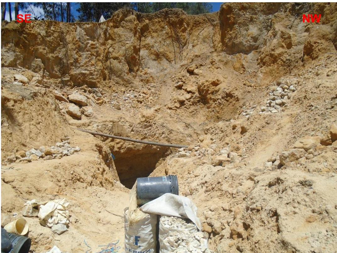
Foto. Socavones que se realizan para la extracción de arcilla y esto nos facilita el muestreo. Ubicación (E: 775727, N: 9204063 y C: 2798 msnm)
