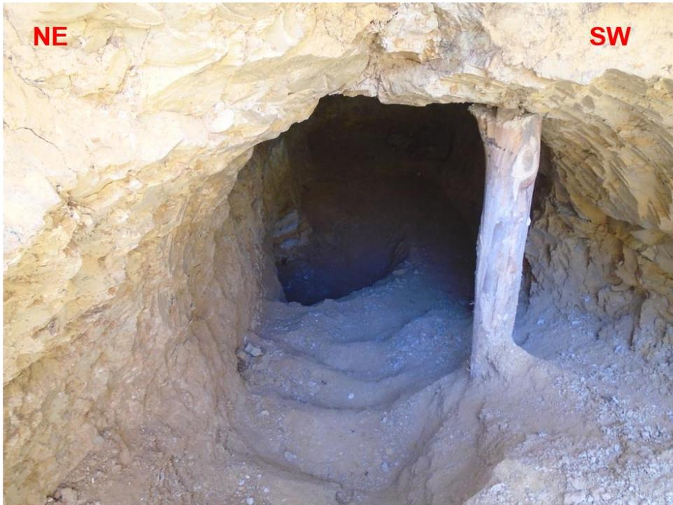
Foto. Socavones que se realizan para la extracción de arcilla y esto nos facilita el muestreo. Ubicación: (E: 775708, N: 9204076 y C: 2796 msnm)
