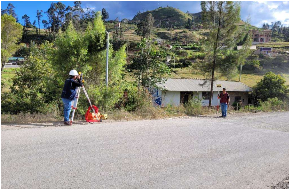
Figura N°03. Toma de datos mediante levantamiento topográfico.
