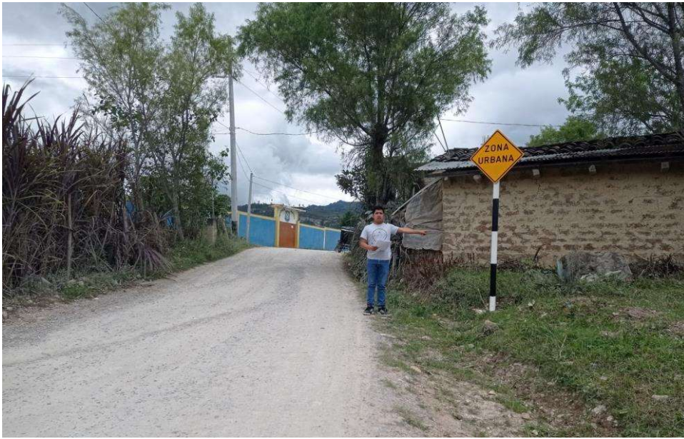
Figura N°19. Señal zona urbana – Km04+284m.
