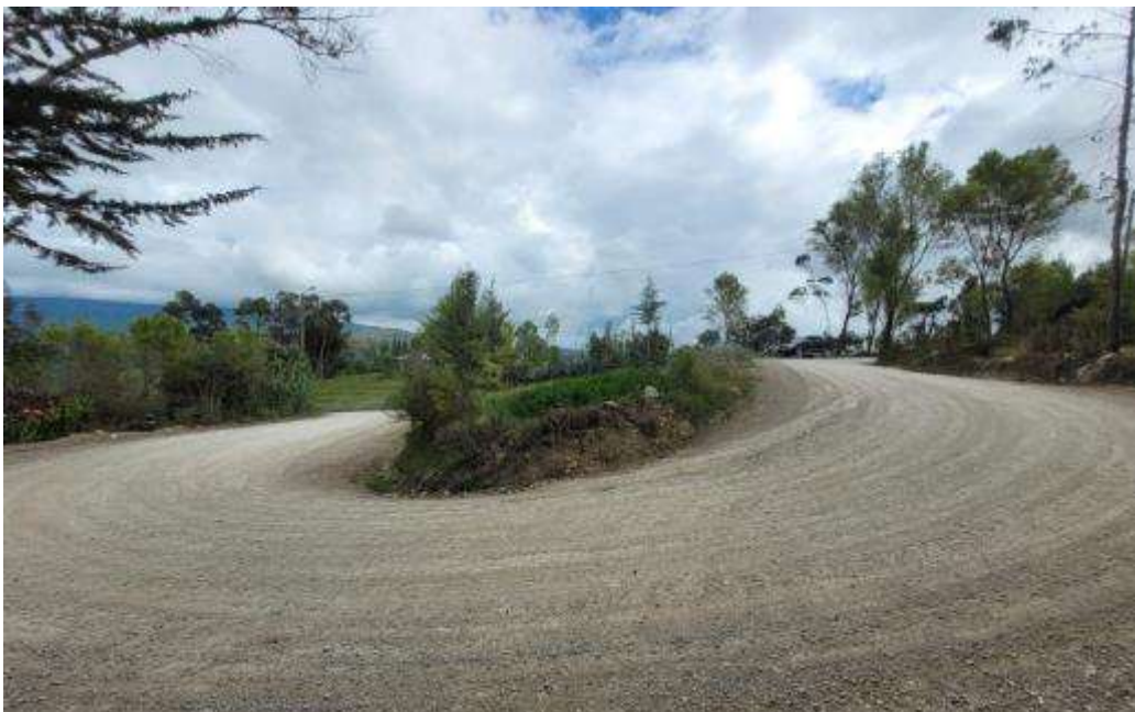
Figura N°16. Curva con radio menor a las permitidas.
