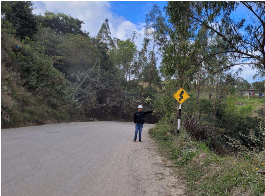
Figura N°21. Señal camino sinuoso a la derecha – Km00+784m.
