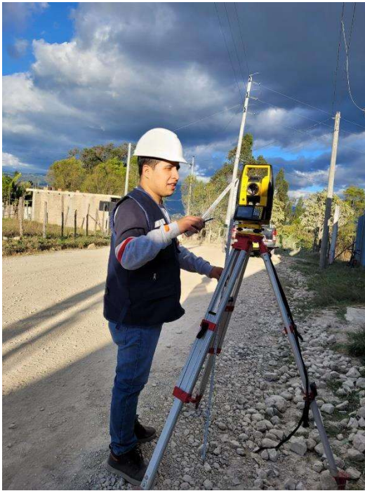
Figura N°07. Estacionamiento del equipo topográfico.
