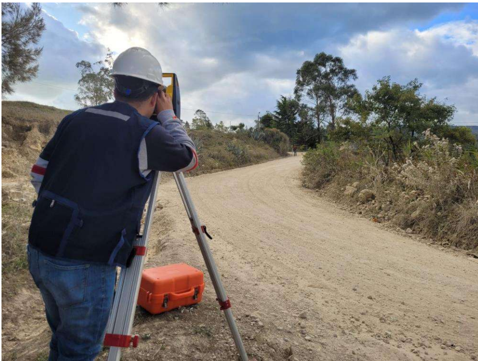
Figura N°04. Toma de datos mediante levantamiento topográfico.
