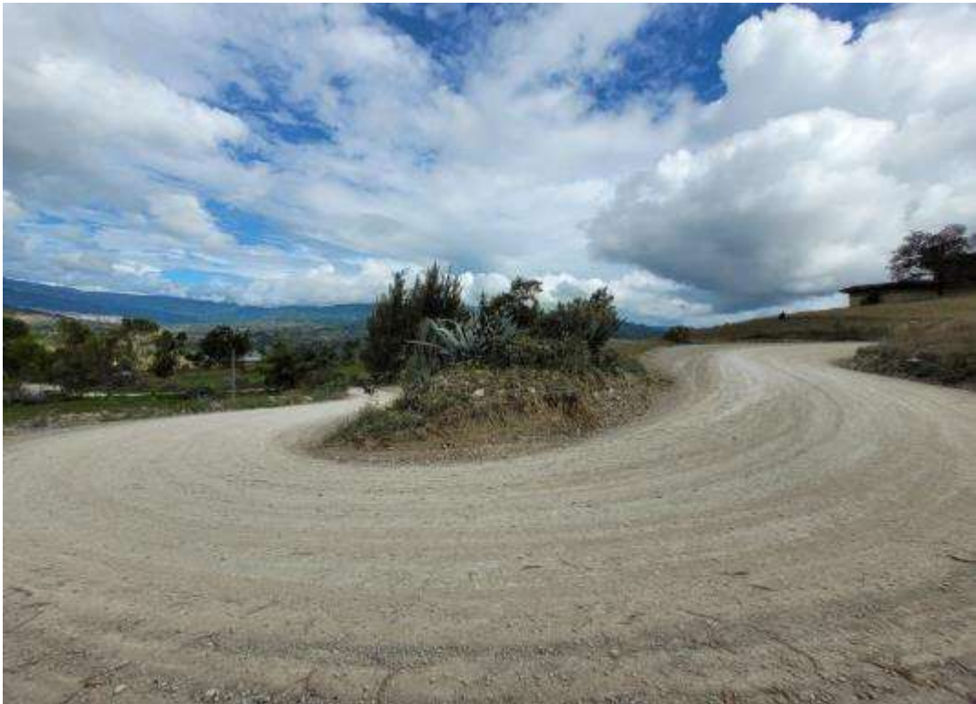
Figura N°17. Curva con radio menor a las permitidas.
