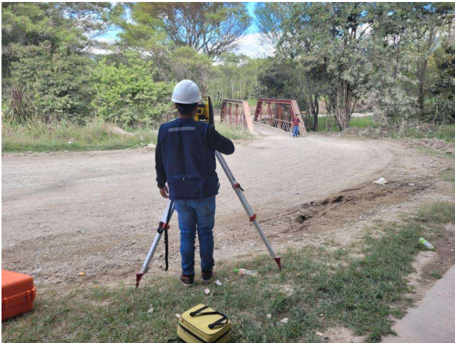
Figura N°06. Toma de datos mediante levantamiento topográfico.
