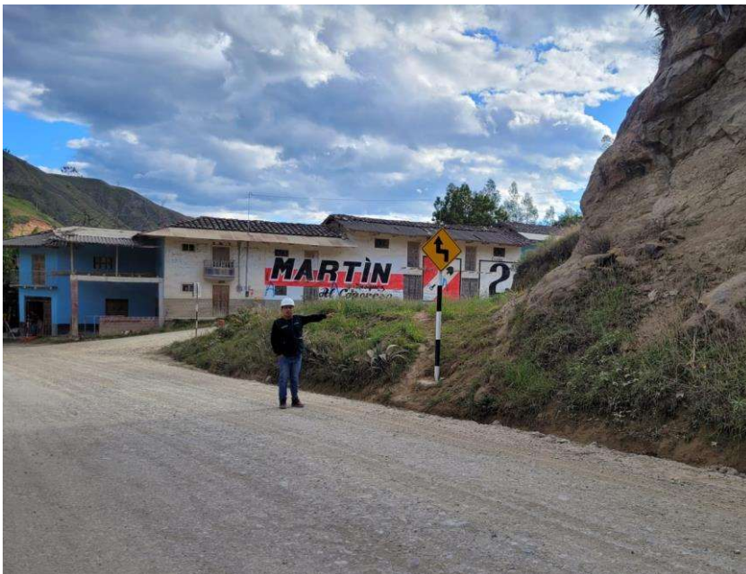
Figura N°22. Señal curva y contra-curva pronunciada a la izquierda - Km00+767m.
