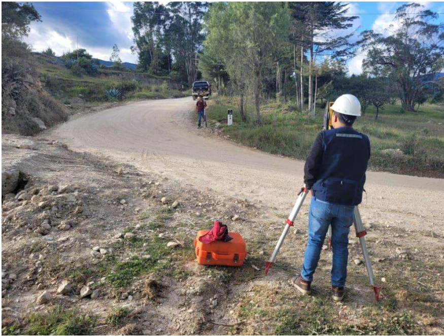
Figura N°05. Toma de datos mediante levantamiento topográfico.
