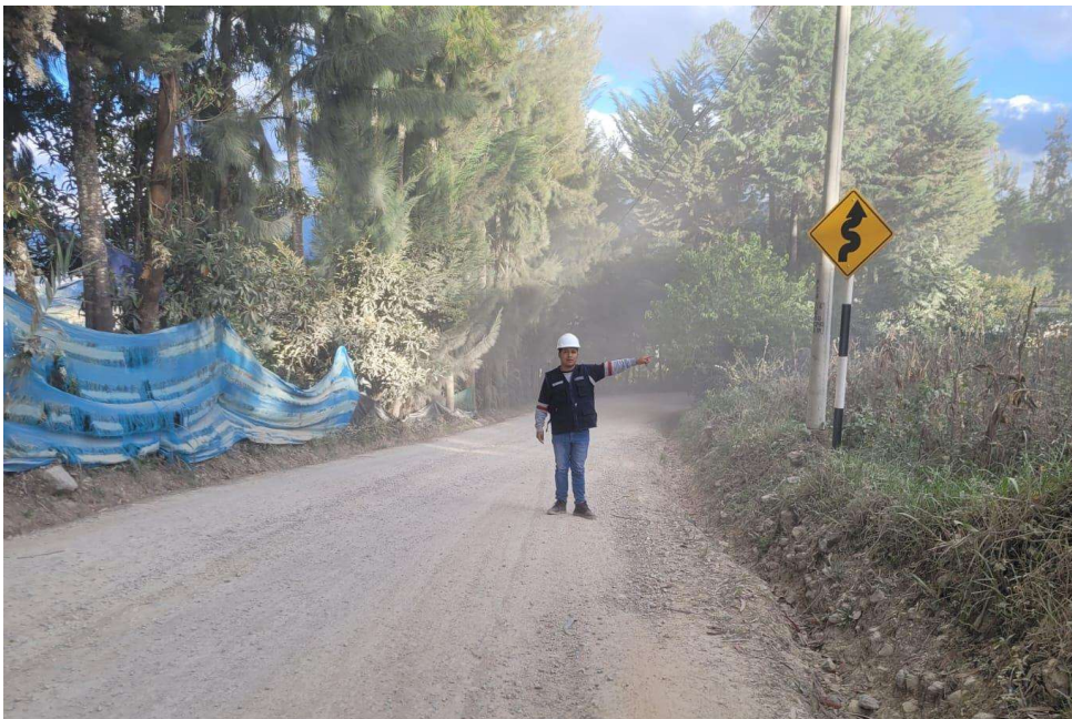
Figura N°20. Señal camino sinuoso a la derecha – Km04+111m.
