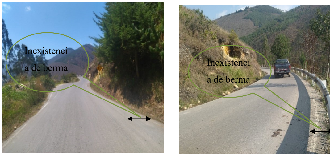
Figura 24. Inexistencia de berma en la mayoría tramos
