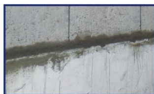
Nivelamiento primera hilada
