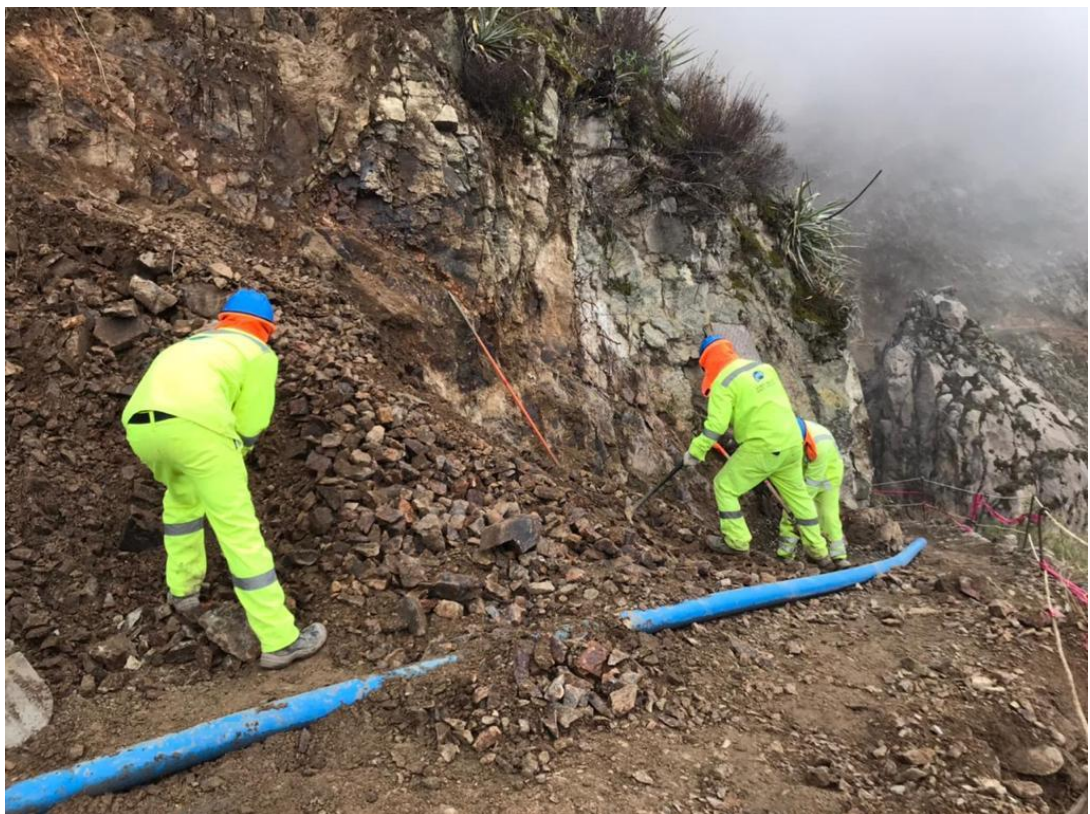
Fotografía N° 24. Partida de “Desbroce y ensanche”.
