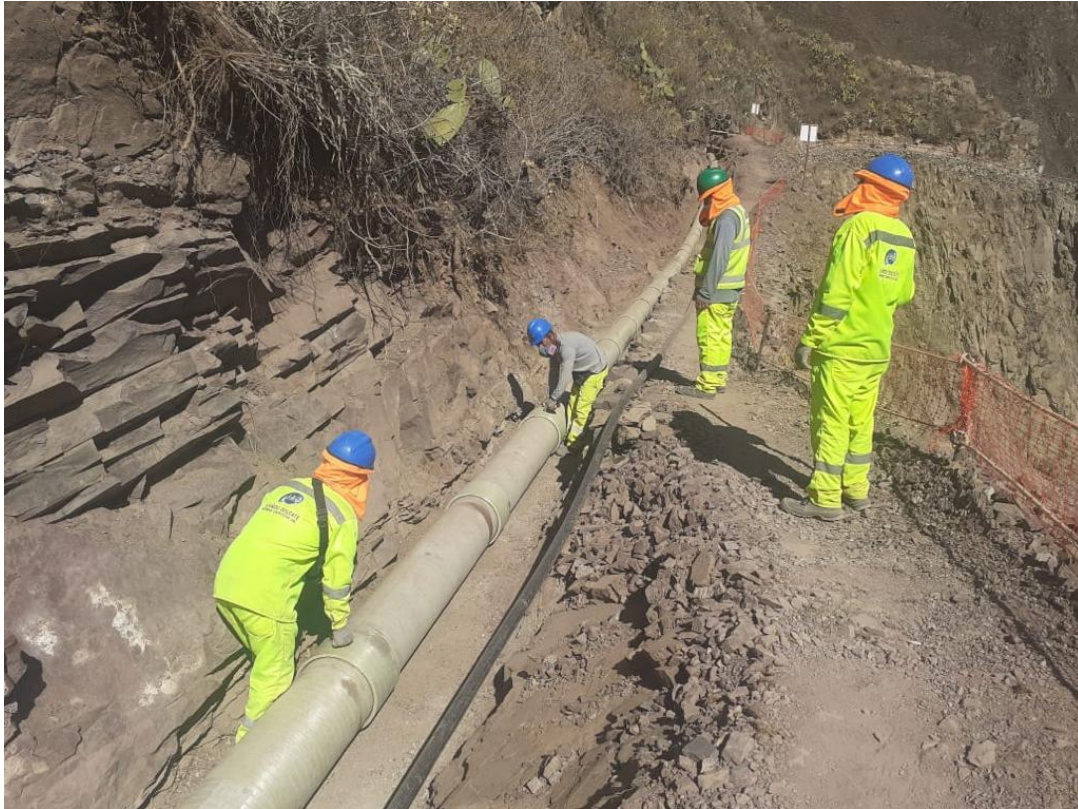
Fotografía N° 19. Partida de “Instalación de tubería” con una persona de observador.
