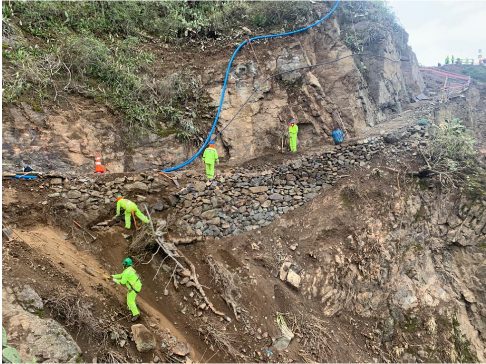
Fotografía N° 07. Construcción de muro seco exterior.
