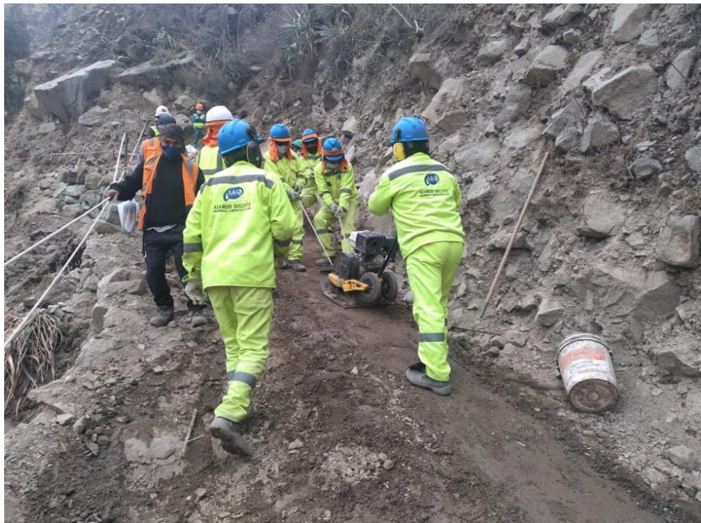
Fotografía N° 03. Partida de “Relleno con material propio zarandeado”, actividad de compactación con equipo. Zona con mayor pendiente.
