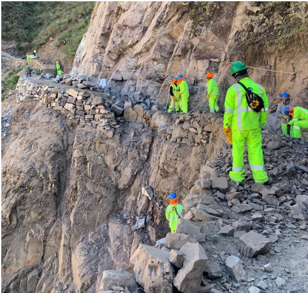
Fotografía N° 08. Construcción de muro seco exterior.
