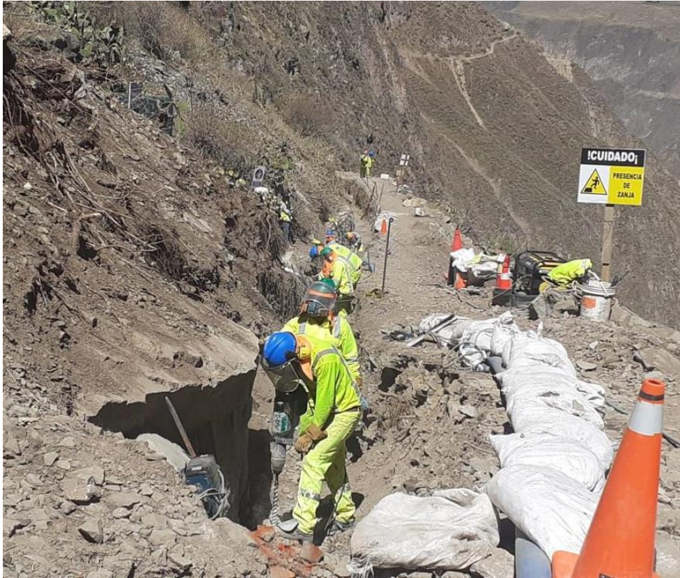
Fotografía N° 13. Partidas de “Perforación en roca” y “excavación en roca fracturada y granular”.
