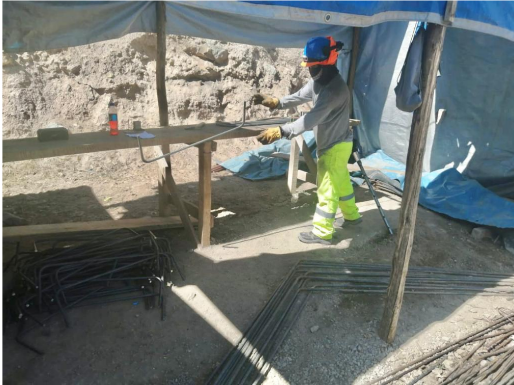
Fotografía N° 25. Partida de “Habilitación y colocación de acero”, actividad de habilitación de acero.
