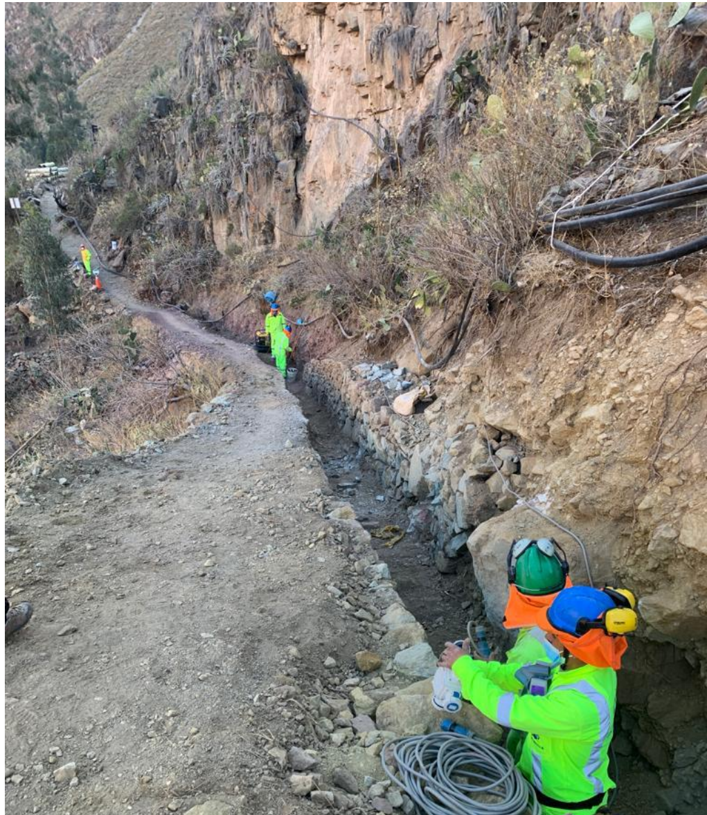
Fotografía N° 08. Muro seco interior construido.
