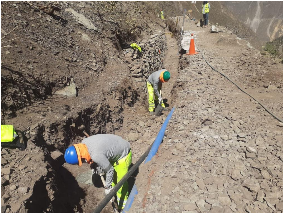
Fotografía N° 16. Partida de “Excavación en material granular”
