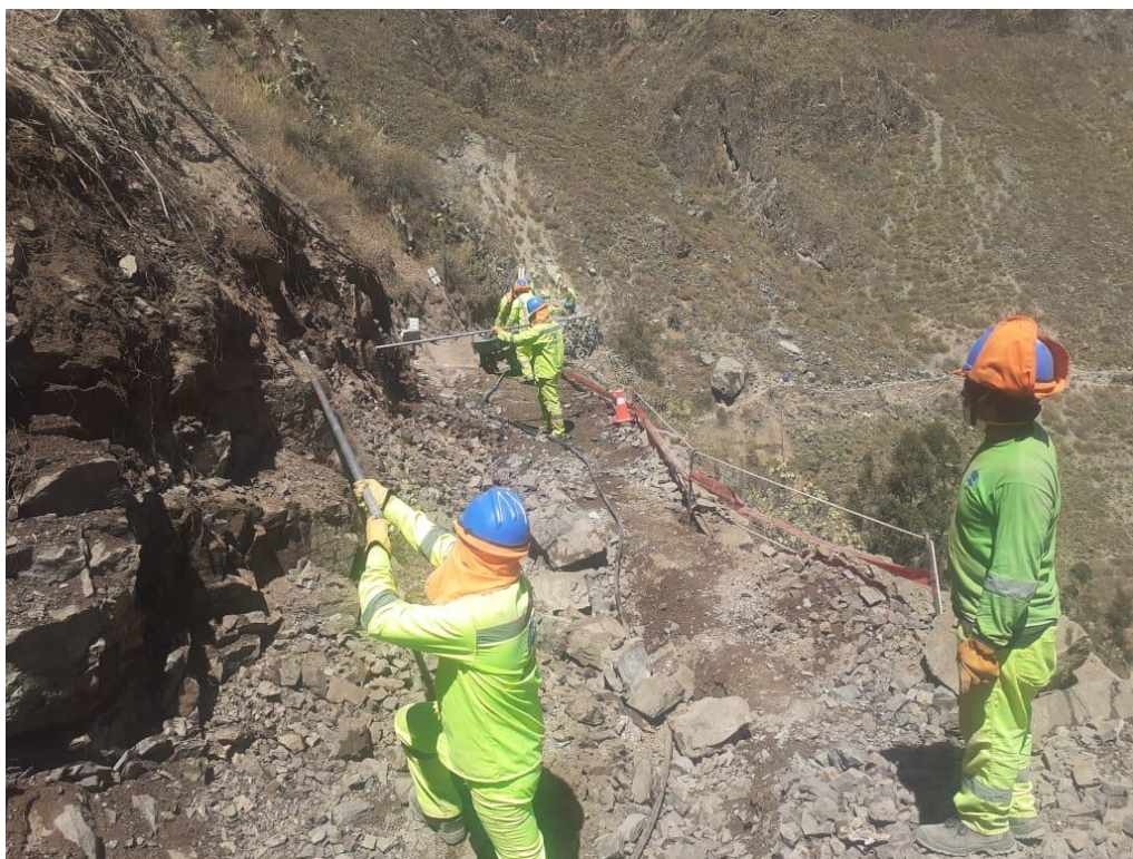
Fotografía N° 05. Desquinche manual de talud.
