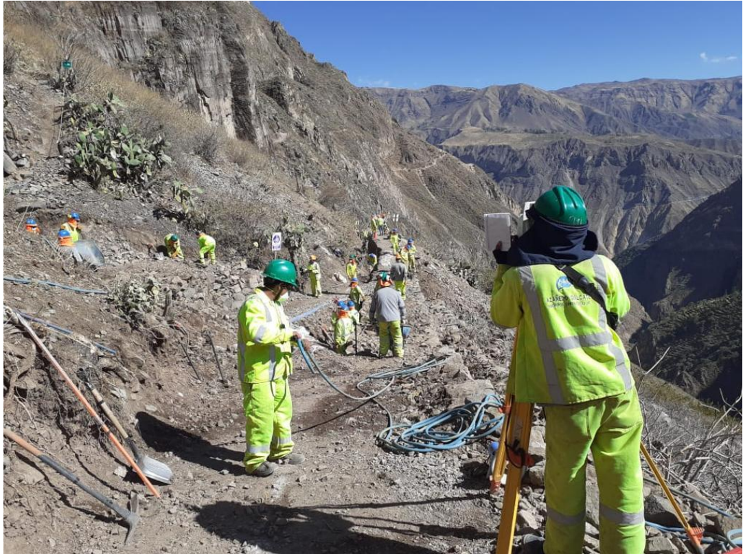
Fotografía N° 23. Partida de “Trazo y replanteo”, actividad de emplantillado de puntos, vista 2.
