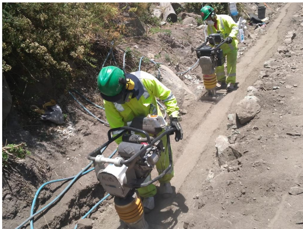
Fotografía N° 01. Partida de “Relleno con material propio zarandeado”, actividad de compactación con equipo. Zona con menor pendiente.
