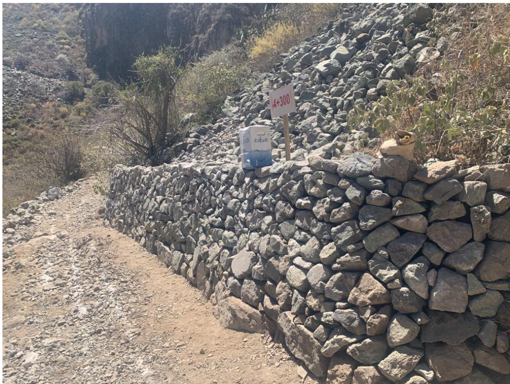
Fotografía N° 28. Muro seco.
