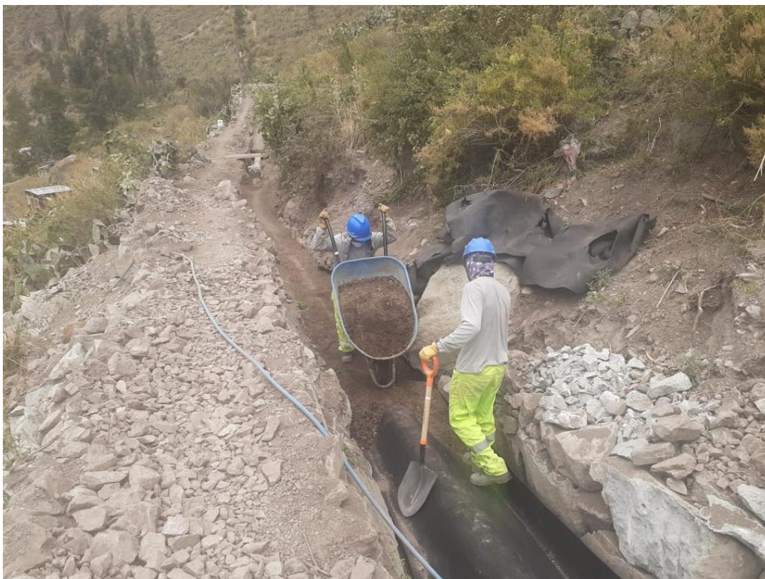
Fotografía N° 20. Partida de “Relleno con material propio zarandeado”.
