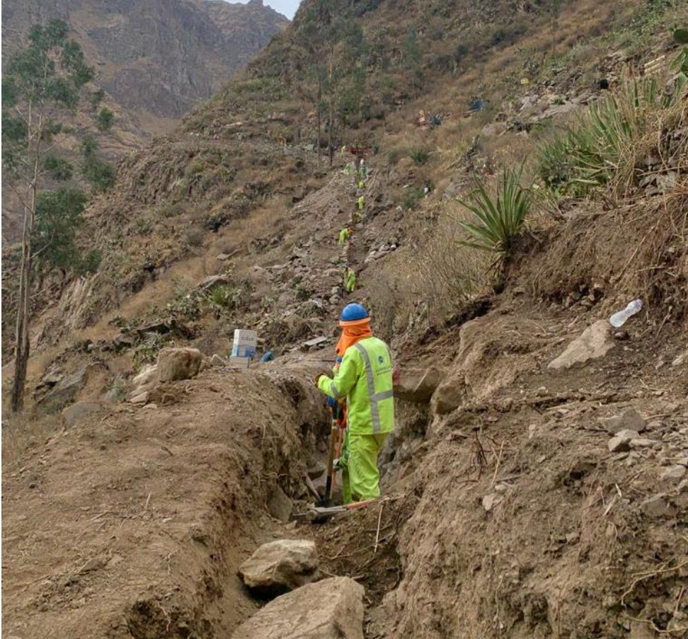
Fotografía N° 15. Partidas de “Perforación en roca” y “excavación en roca fracturada y granular”, vista 2.
