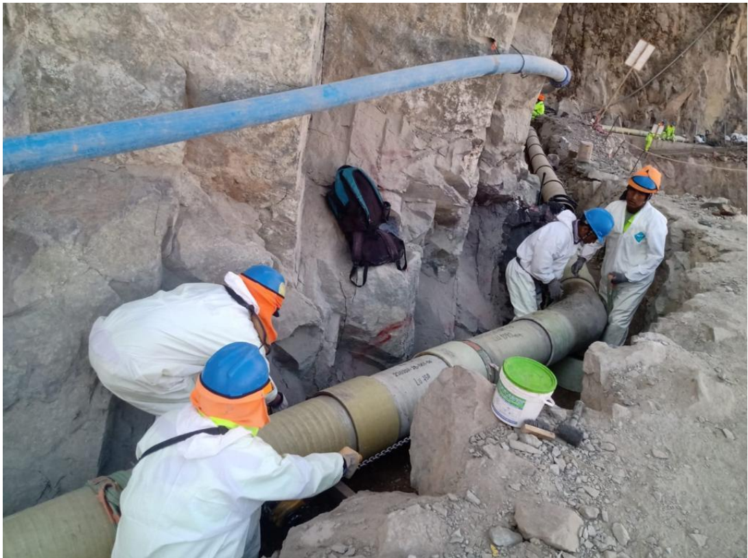
Fotografía N° 18. Partida de “Instalación de tubería”.
