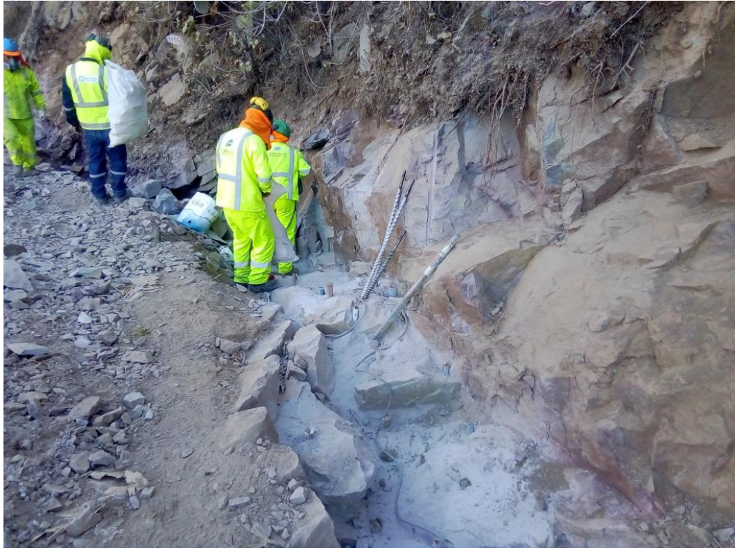
Fotografía N° 21. Partida de “Perforación en roca”.
