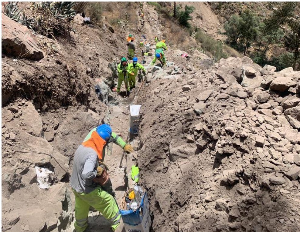
Fotografía N° 14. Partidas de “Perforación en roca” y “excavación en roca fracturada y granular”, vista 1.
