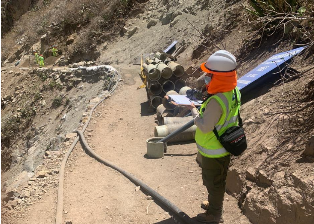
Fotografía N° 09. Realizando la medición de la partida de “Relleno con material propio zarandeado”, actividad de “acopio y zarandeo”.
