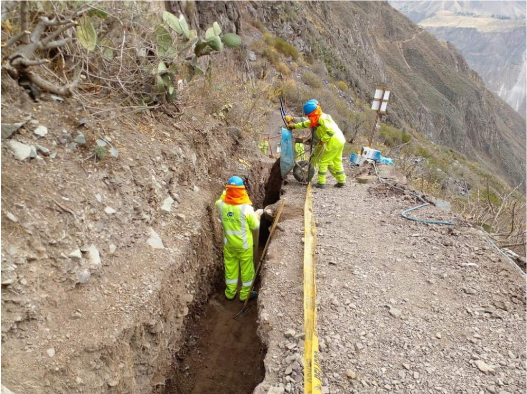
Fotografía N° 17. Partida de “Colocación cama de arena”.
