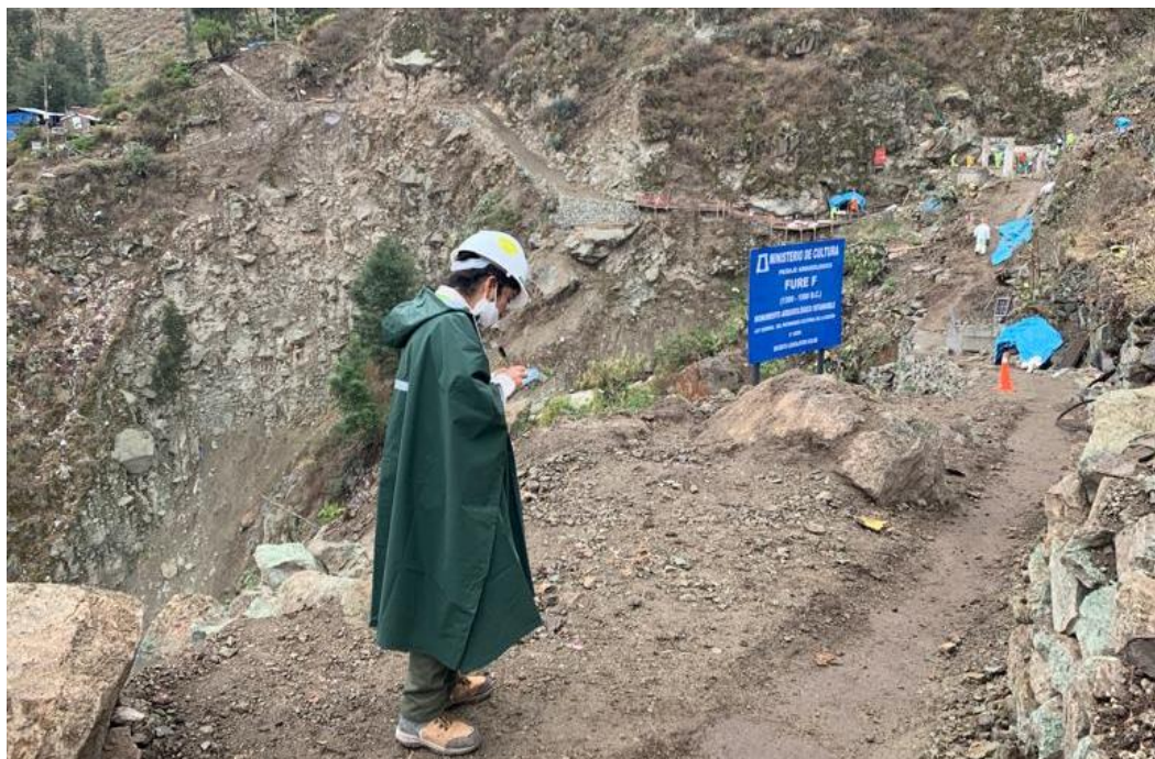
Fotografía N° 10. Realizando anotaciones dentro de obra.
